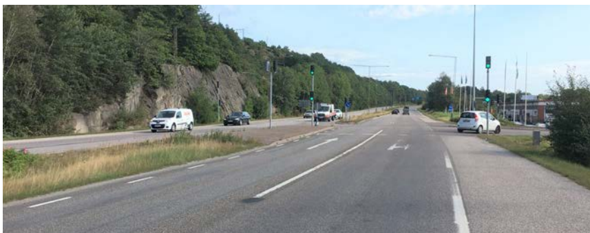
Vy över Marstrandsvägen mot nordost. Den trafikljusreglerade korsningen är korsningen med Christian IV:s väg. Foto från kommunen.
