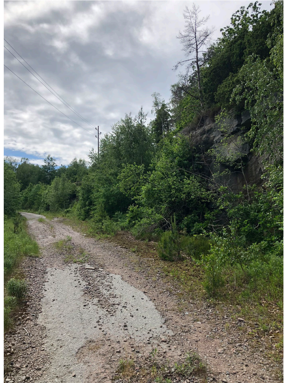
Den befintliga vägen kantas delvis av branta bergväggar. Foton från platsbesök 2021-06-10.
