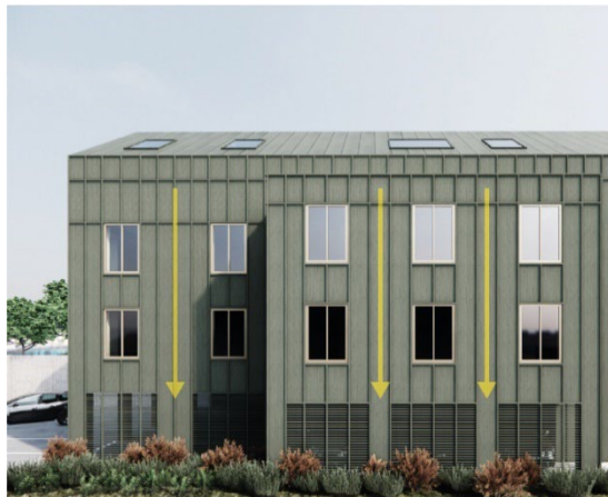
Bild 12. Exempelillustration över parkeringsvåning i bottenplan med halvöppen fasad (ribbor). Fasadelement från ovanstående bostadsvåningar följer med ned över parkeringsvåningen (gula pilar). Illustration av Högberg Gillner Arkitektur. Bilden har justerats av Kungälv kommun.
