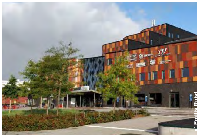
Kviberg Arena i Göteborg har en väl sammanhållen gestaltning där material, formspråk, färgsättning och växtmaterial är genomgående i hela området. Den röda böljande fasaden är karaktärgivande och bottenvåningen är bitvis uppglasad så att man kan ta del av innehållet i byggnaden.
