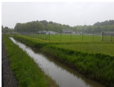
Dike längs Yttervägen
