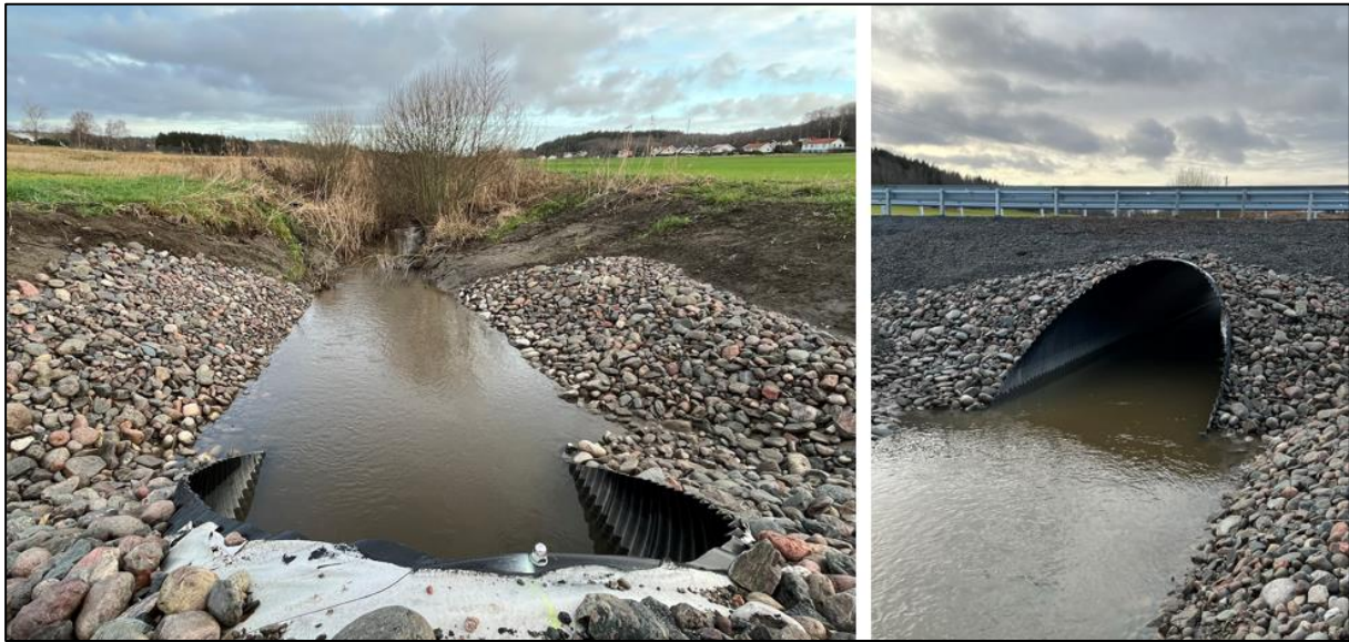
Figur 4. Trumma Sydost Ø 2 500 mm.
