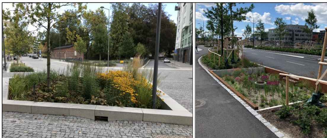
Figur 11. Exempel på nedsänkta regnbäddar (Foton: Norconsult).
