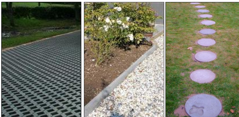
Figur 16. Yta med hålsten av betong, makadambelagd gång, samt gångstig med gräs och några gångplattor i betong (Foto: Norconsult).
