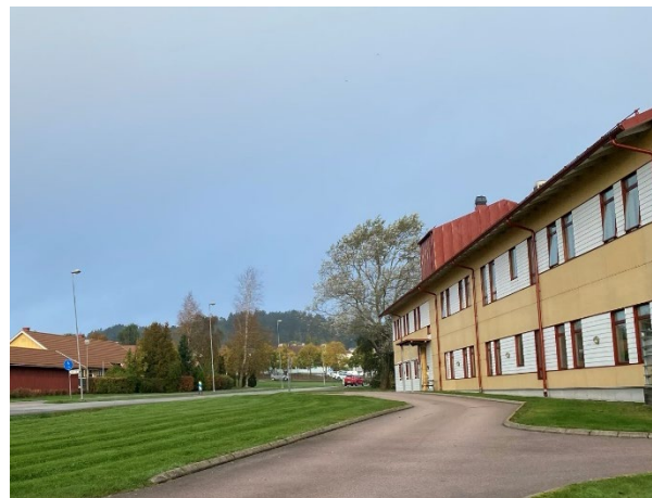
Ytterbyhemmet och tandvårdcentral väster om planområde. Vy mot väster
