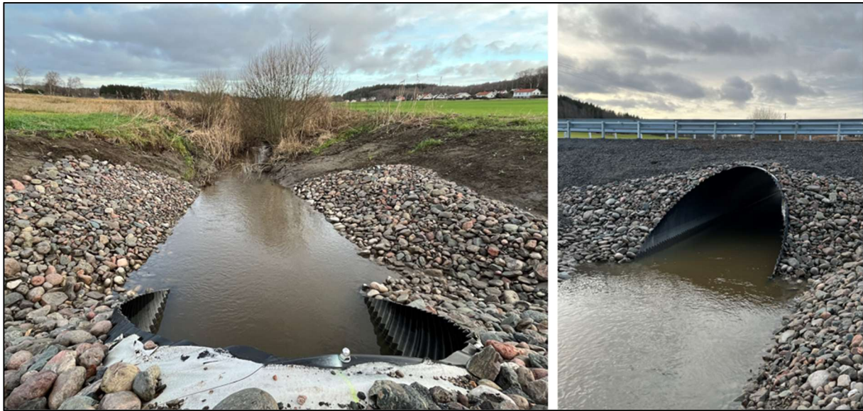
Figur 4. Trumma Sydost Ø 2 500 mm.
