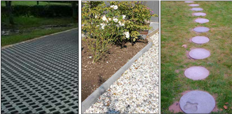
Figur 16. Yta med hålsten av betong, makadambelagd gång, samt gångstig med gräs och några gångplattor i betong (Foto: Norconsult).
