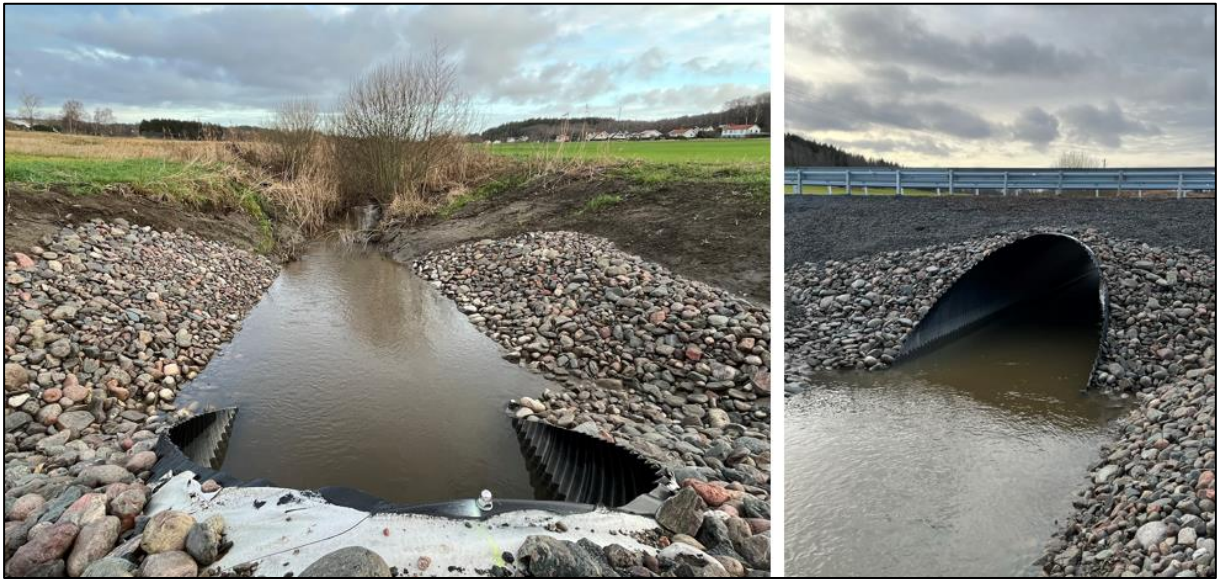
Figur 4. Trumma Sydost Ø 2 500 mm.
