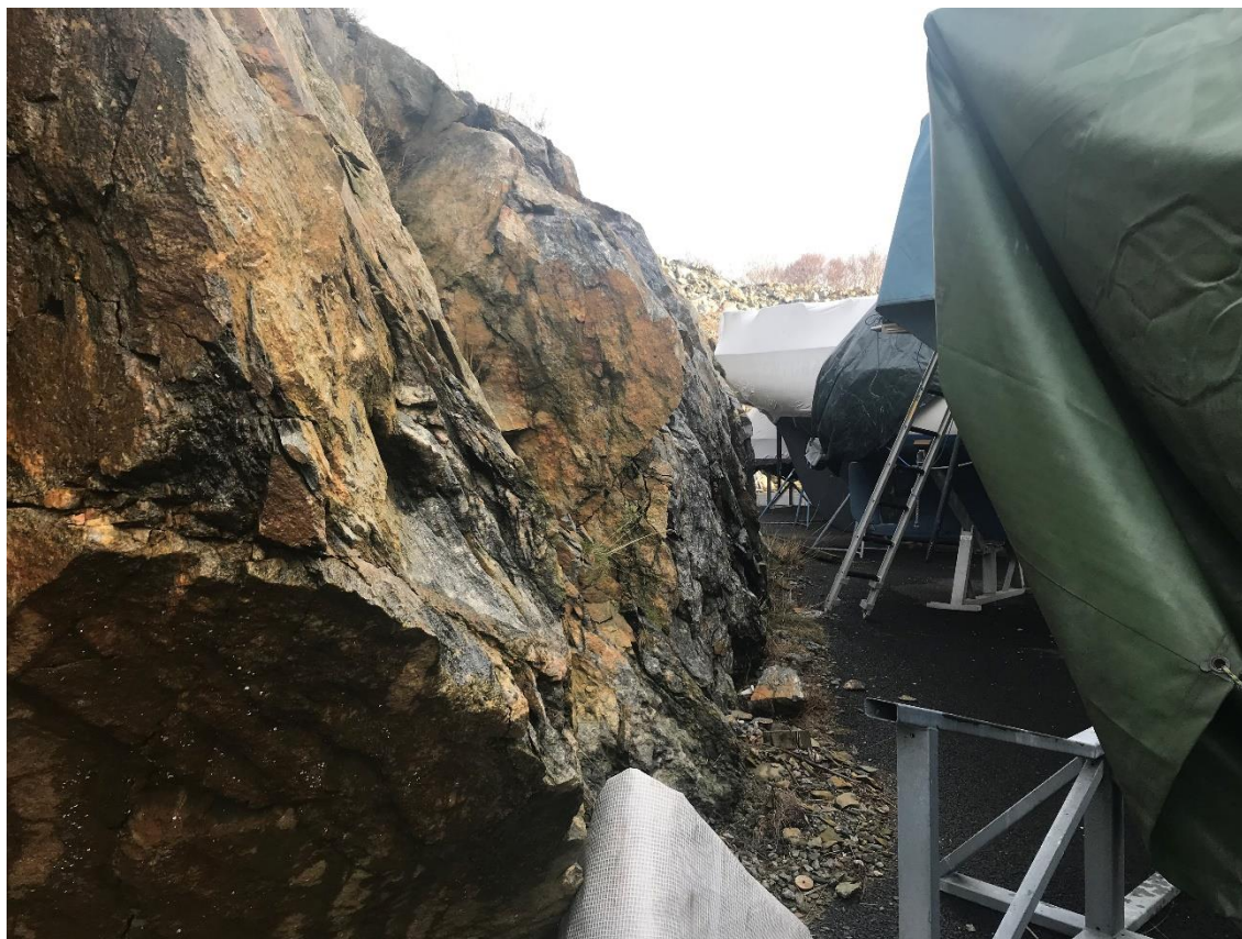
Figur 6. Nedrasade stenar och block i den östra skärningen.
