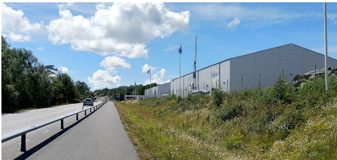
Befintliga båthallar i förhållande till väg 168 och cykelvägen
