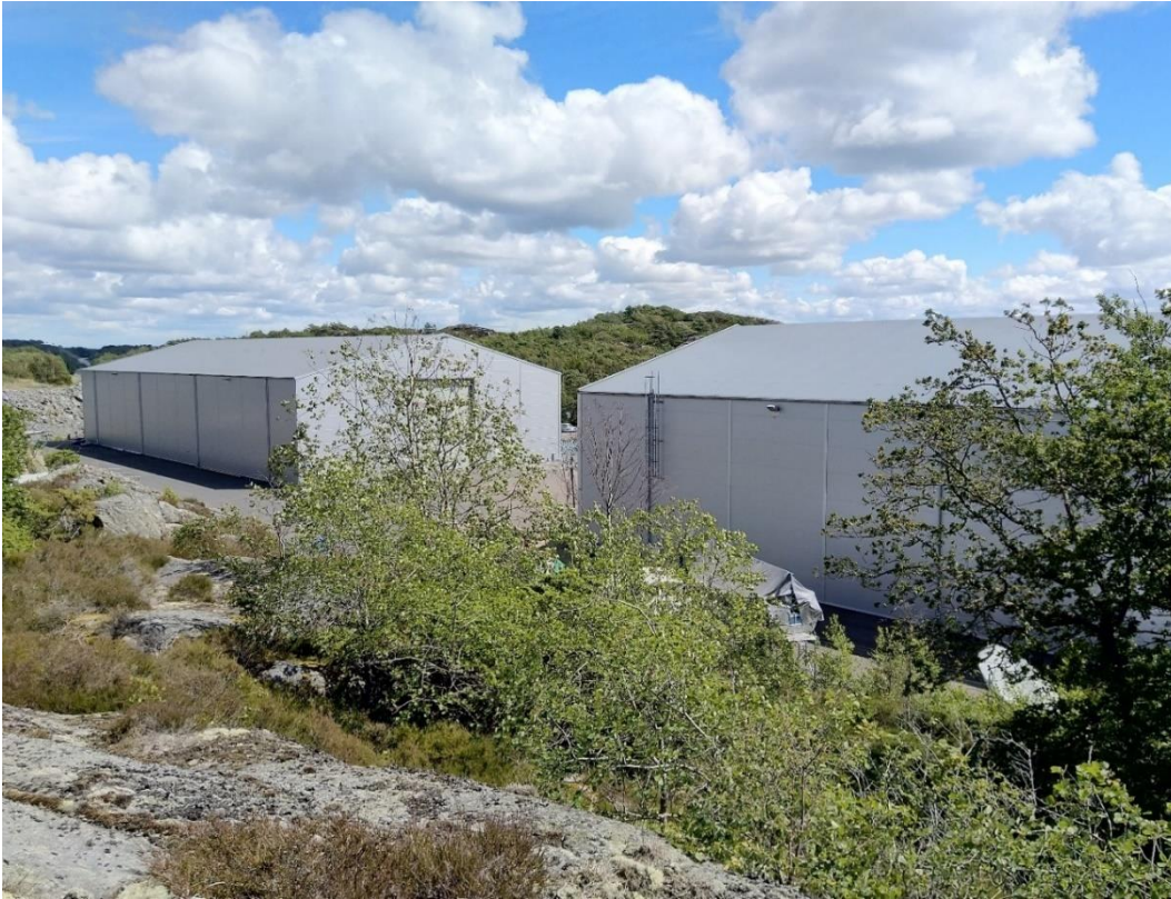
Befintliga båthallar är ca 13,5 m höga (nockhöjd). Blick från nordväst mot sydöst.
