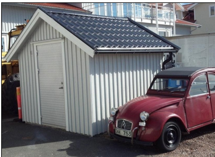
Figur 6. Överbyggnaden till Badhålans pumpstation
