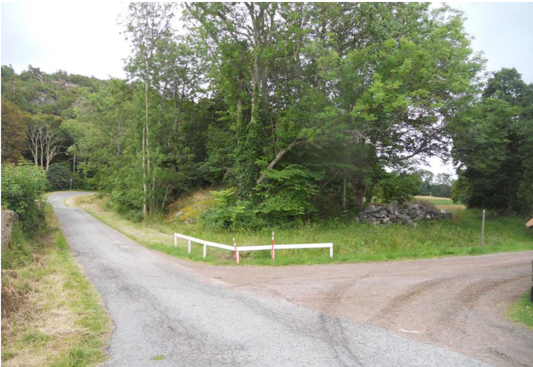
Tjällviksvägens nuvarande sträckning till vänster. Till höger Djupuddsvägen med den gamla avfarten till Tjällviksvägens sträckning norr om odlingslandskapet.
