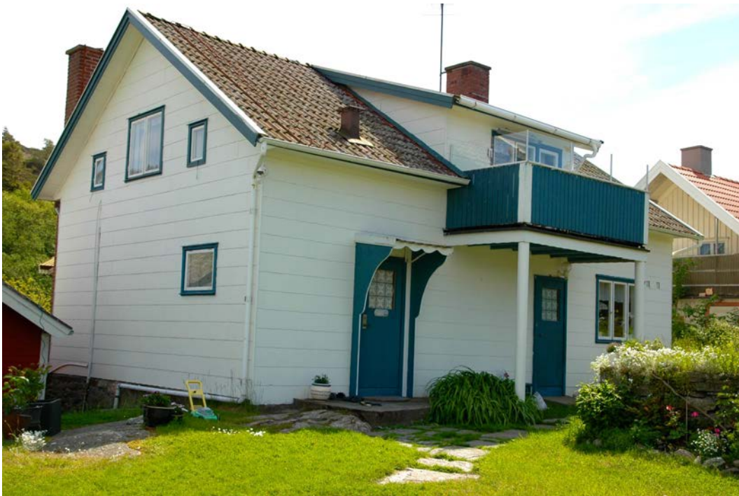
Bostadshuset för Instön 1:234 som blev moderniserat under 1950-talet.
