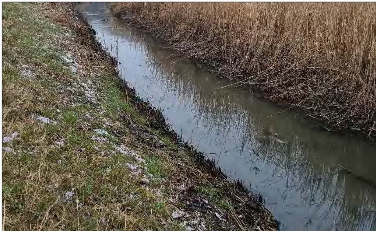
Figur 6-5 - Bild tagen vid vattendrag längs Ytterbyvägen. Ingen märkvärdig pågående erosion kan observeras (Dec, 2022).
