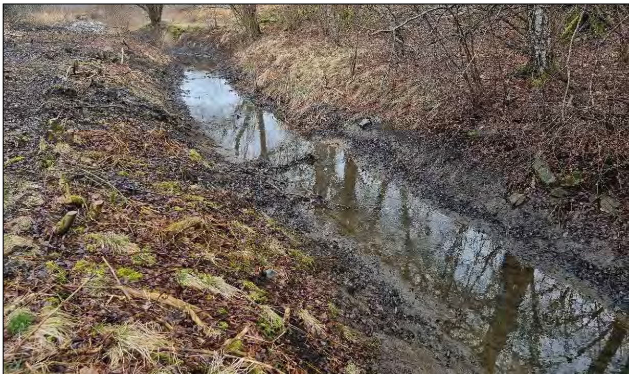
Figur 6-6 - Bild tagen vid bäck längs GC-väg mellan Ytterbyvägen och Marstrandsvägen. Ingen märkvärdig pågående erosion kan observeras (Dec, 2022).
