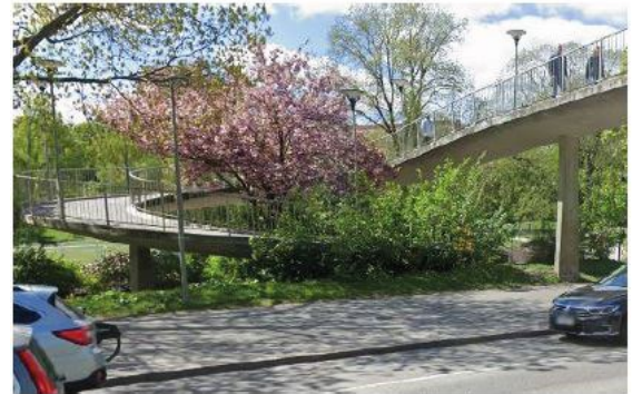
Exempel på gång- och cykelbro som avslutas med en snurra i Rålambshovsparken i Stockholm
