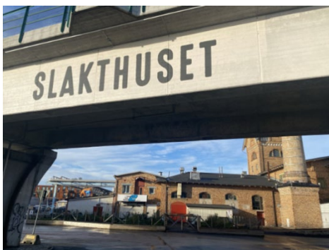
Exempel på bro som fungerar som identitetsskapare och som annonserar en tydlig entré till Slakthusområdet i Göteborg.
