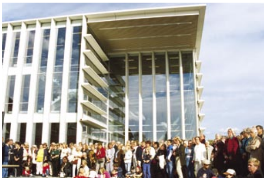
För gymnasieförvaltningen präglades 2004 av inflyttningen i Mimers Hus. Många Kungälvbor kom för att vara med vid invigningen den 25 september.
