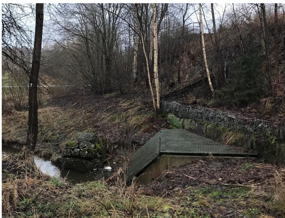
Figur 27. Stödkonstruktion och kulvertering av vattendraget under Bohusbanan vid observationspunkt CW9 (COWI AB, 2019)
