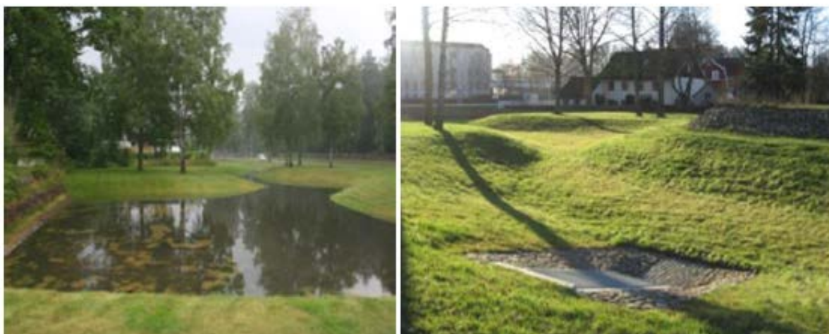
Bild 28; exempel på dagvattendammar i Växjö under torrt och vått väder (SWEKO, 2016)
