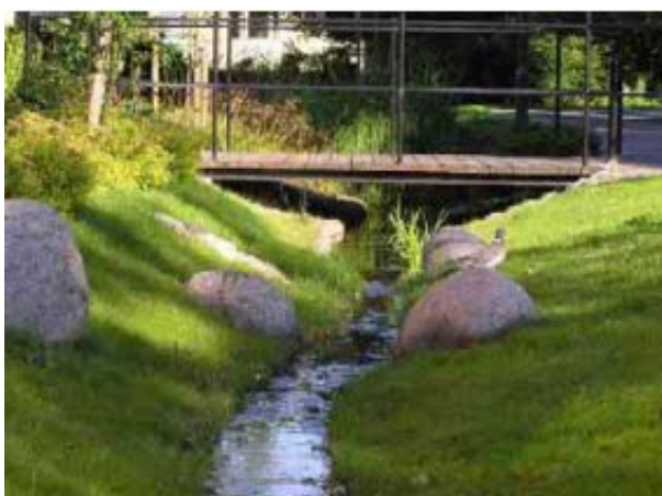
Bild 29; exempel på öppen avledning av dagvatten i dike,
