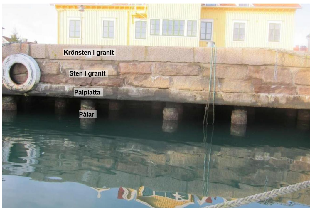
Figur 4. Kajfront med pålar, pålplatta, två lager sten i granit och överst krönsten i granit. Figur av ELU (ELU, 2022).
