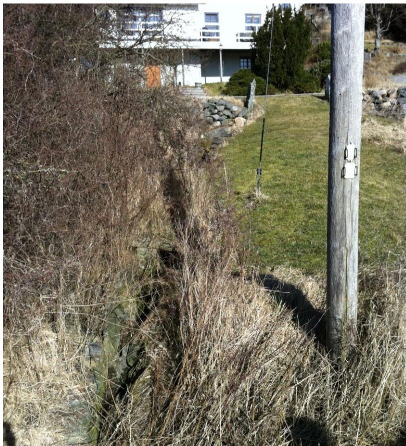
Figur 10. Öppet dike med stensatta trummor vid väggörningar, för avledning av dagvatten från den södra delen av Stenstavägen, mm
