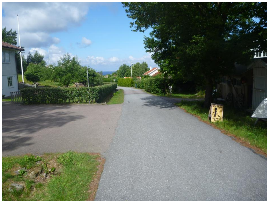
Figur 20. Gata med mindre vägdike genom nordvästra Matskären
