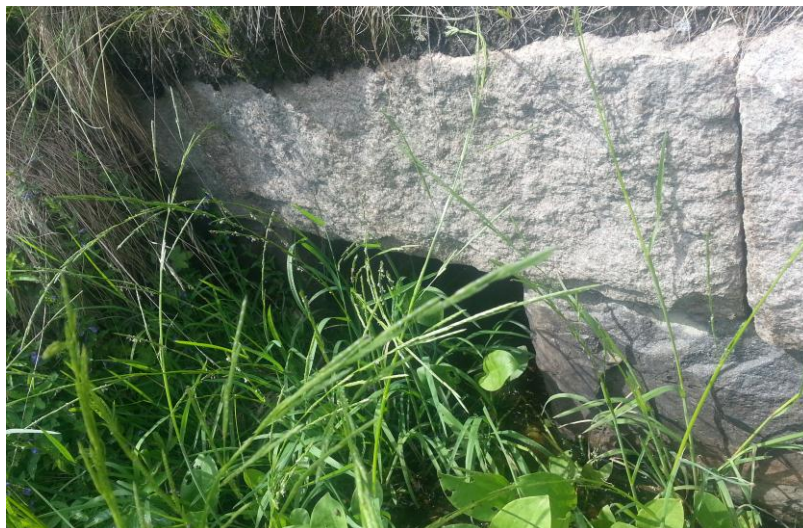
Figur 24. Kulvertering under väg 168 i form av murad stentrumma. Denna förbinder delområde 10 och 11.
