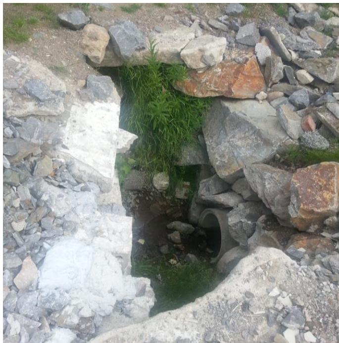
Figur 26. Uppsamlingsgrop med en 400 mm utgående betongtrumma.
