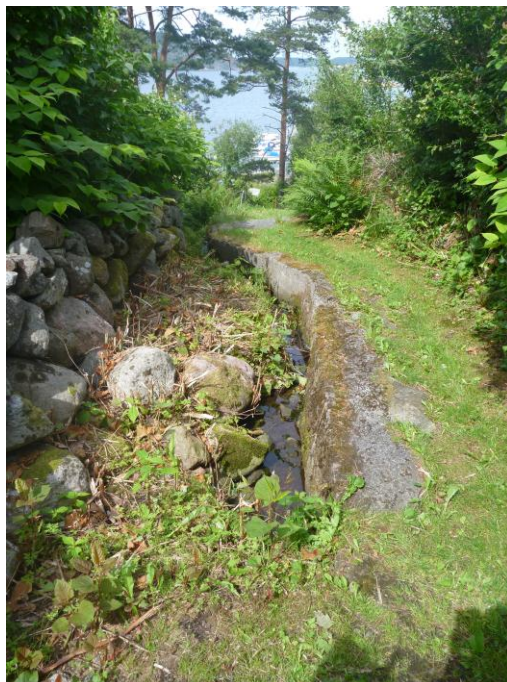
Figur 19. Diket från våtmarken i öster går sträckvis i en betongkonstruktion ner mot havet.
