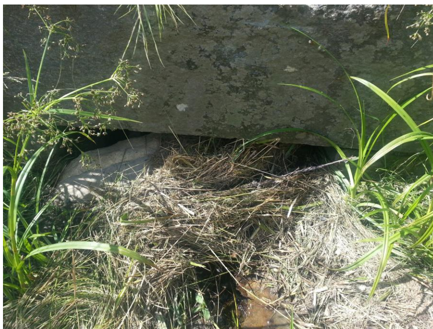
Figur 22. Stentrumma under väg 168 mellan Stenskärsvägen och Norgårdsvägen, sett från Stenskärsvägen.
