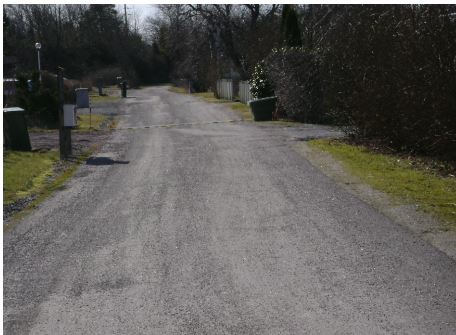
Figur 7. Makadamdike längs med vägen i Intaget
