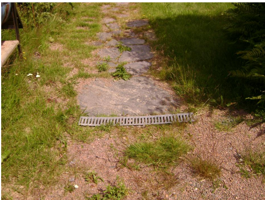
Figur 16. Dagvattenränna, som skall hindra ytvattenavrinning mot tomtmarken norr om vändplanen
