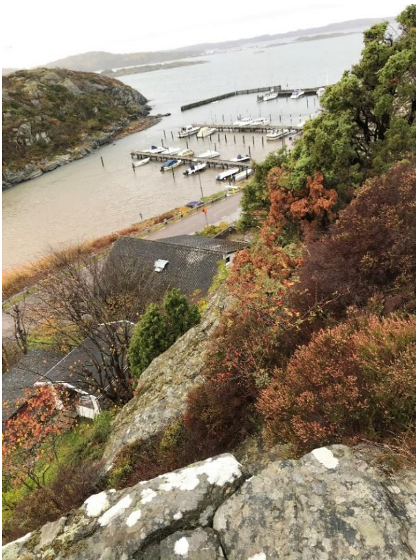
Figur 10. Bild uppe från slänten ner mot bebyggelsen söderut. Taket bedömds utifrån okulär besiktning från avstånd utgöras av eternitplattor. Asbest och därmed eternittak förbjöds för nyanvändning ca 1976 men en del levde kvar till 1982 vilket innebär att taket inte drabbats av nedfallande sten och block, åtminstone sen dess.
