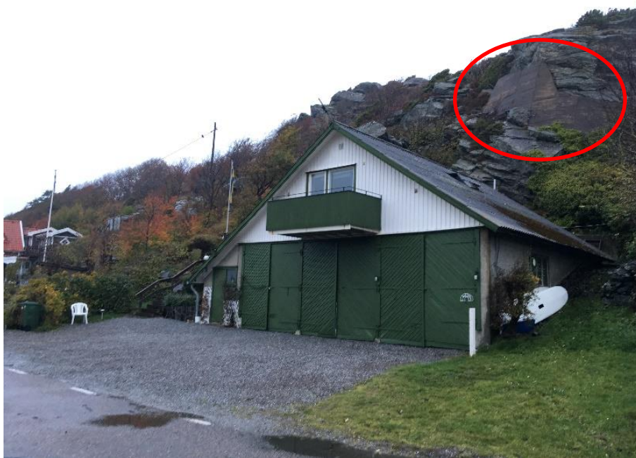
Figur 12. Röd ring markerar betongklack (bergförstärkning) i slänten ovan huset.
