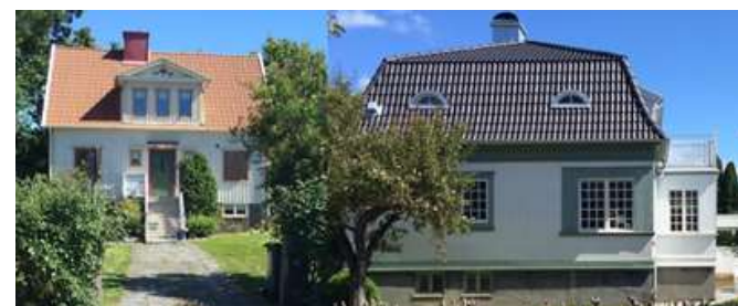
BEVARANDEVÄRDVILLOR I KVARTERET PORTMADEN.
