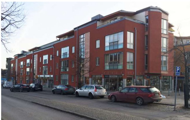
TORSBYVÄGEN KAN I FRAMTIDEN UTFORMAS SOM EN EN STADSGATA MED BEBYGGELSE SOM KANTARVÄGEN. FOTO FRÅN STRANDGATAN.
