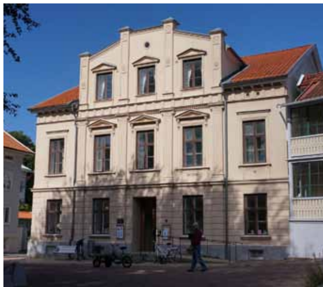
Rådhuset vid torget. Delar av byggnaden härstammar från 1600-talet. Byggnaden är kraftigt ombyggd på 1800-talet.
