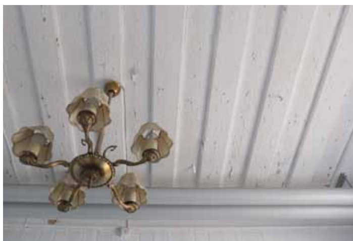
Ursprunglig takpanel med svagt profilerade kanter samt taklist från 1858.
