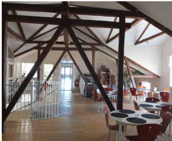
Övre våningen med det dominerande stora allrummet med trappan, frontespis och omfattande träbalksystem.
