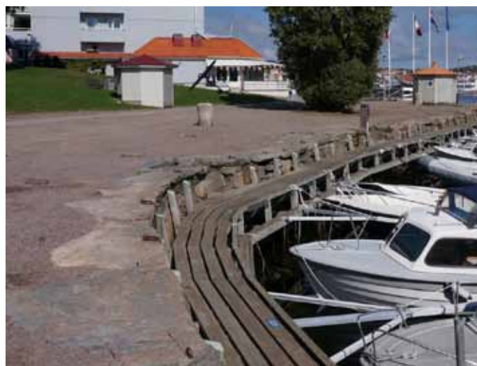
Delar av den äldre kajkanten finns bevarad.
