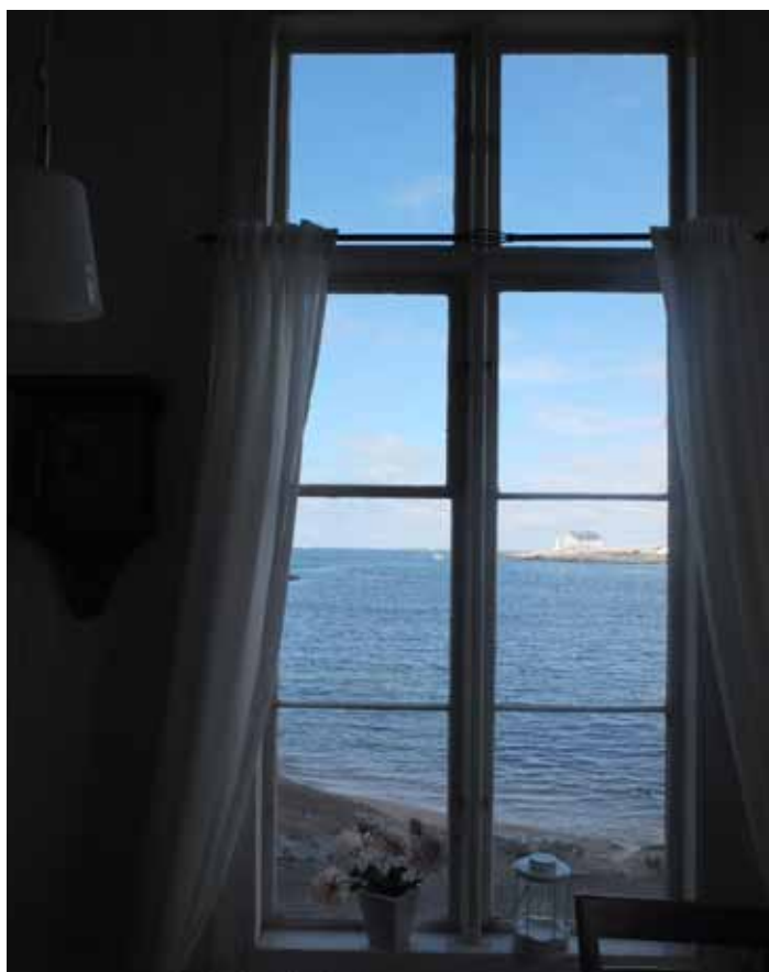
Fönster med ursprunglig hög ytterbåge ned mitt- och tvärpost samt vertikala spröjs från 1858.
