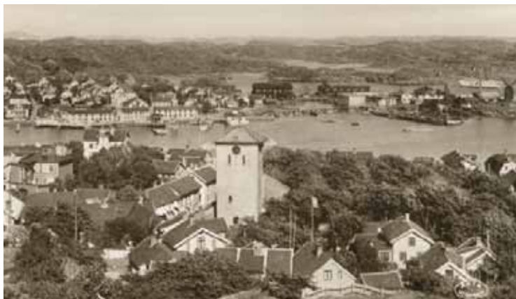
Marstrands kyrka 1943. Delar av den medeltida kyrkobyggnaden finns bevarad i murverket. Bilden tillhör Bohusläns museum.
