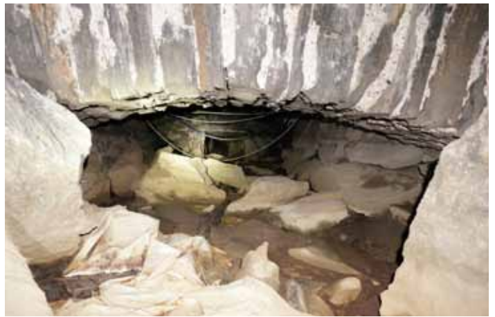
Havsvattenkanalen och valv av natursten.
