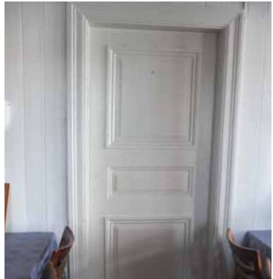
Ursprunglig fyllnadsdörr med profilerade lister och foder från 1858.
