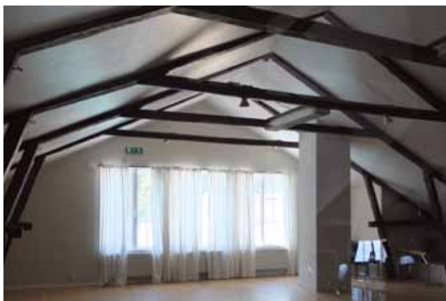
Konferensrummet med fönster mot baksidan i sydväst. Synlig takstolskonstruktion.
