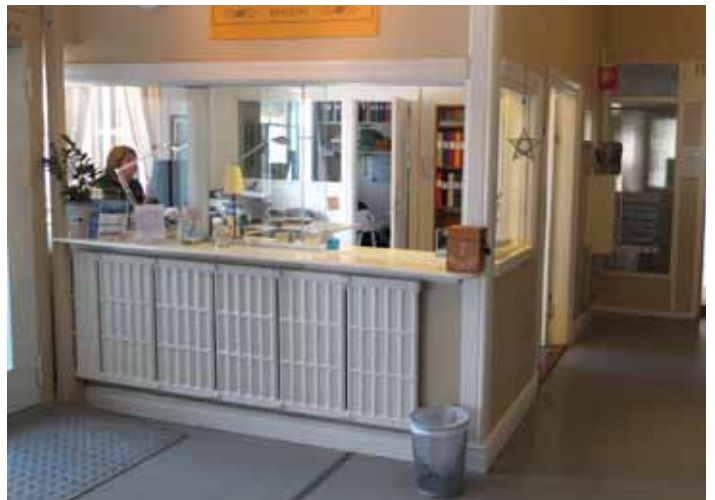
Receptionen med äldre gjutjärnsradiatorer.
