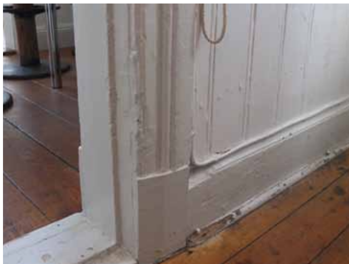
Golvsockel, fodersockel dörrfoder, tröskel och pärlspåntspanel i hantverksmässigt utförande från 1858.
