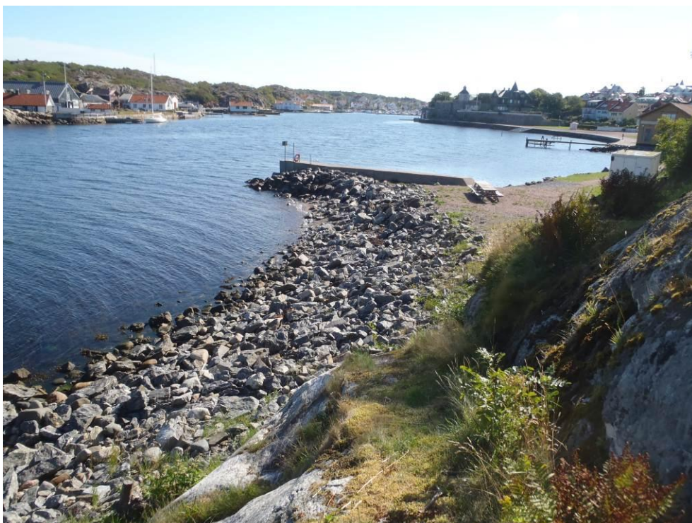
Stora delar av områdets stränder är utfyllda med sprängsten.
