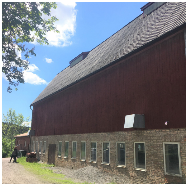
Den murade stalldelen och ovan detta höskullen med dess höga rödfärgade väggliv och ett nedre takfall med takkupor. Längst bak i bild anas det nyare mjölkrummet.
