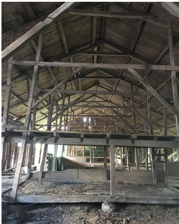
Stolpverkskonstruktionen med ett av de två upphöjda loftbjälklagen i förgrunden och där bakom det rymliga mittpartiet med möjlighet till genomkörning rakt igenom.
