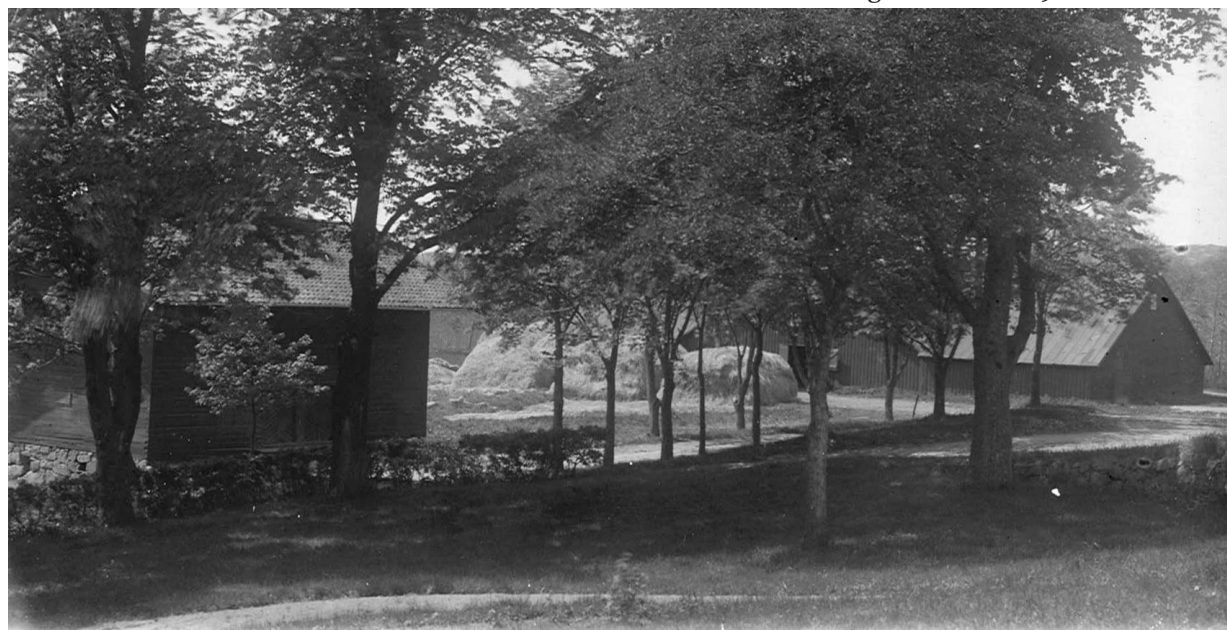
Foto från 1930-40-talet över den södra gårdsmiljön med det timrade magasinet till vänster i bild och ladan till höger. Ladans takfall är längre neddraget än idag samt att en bred gavel med körport kan anas bakom det upplagda höet vid den östra långsidan. Noterbart är också att miljön längs vägen är gestaltad med en närmast parkliknande växtlighet med gräsytor, allé och klippt häck. Foto hämtat från nuvarande arrendator av marken vid gården.
