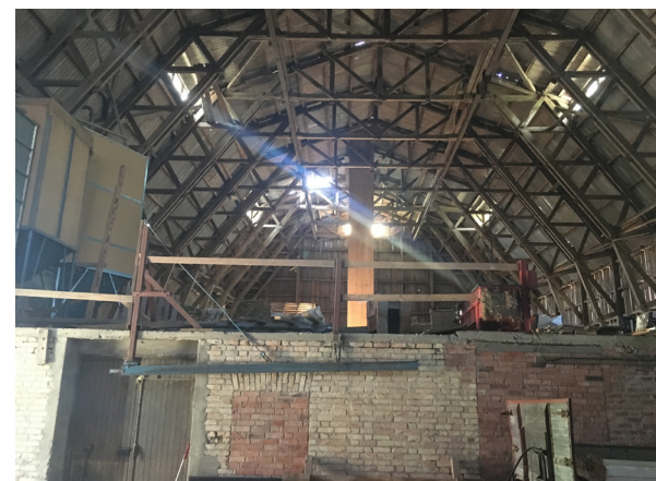
Ladugårdens fackverkskonstruktion i trä är byggnadstekniskt värdefull och bidrar till stor rymd på insidan.
