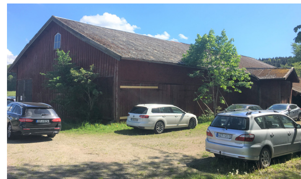
Norra gaveln och västra långsidan med dess utbyggda körport och ett öppet väggparti med neddraget takfall.
