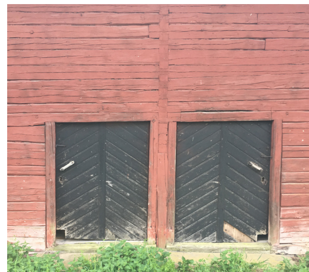
Detalj från norra långsidan visande den "lappade och laggade" timmerväggen och de panelklädda dörrarna med deras tämligen ålderdomliga utformning.
