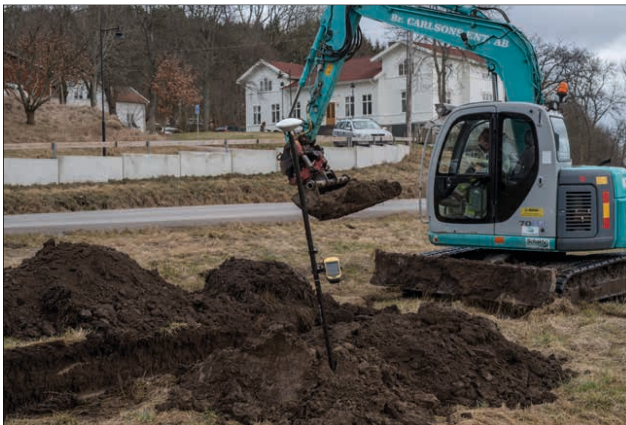
Figur 3. Vy mot Trankärrsgården under schaktning. Foto mot nordöst.
