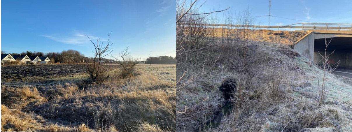
Figur 21. Vallbyåns biflöde syns i mitten av bilden till vänster. Ny blandad bebyggelse planeras på båda sidor om ån. I bilden till höger visas dike och trumma under E6:an.
