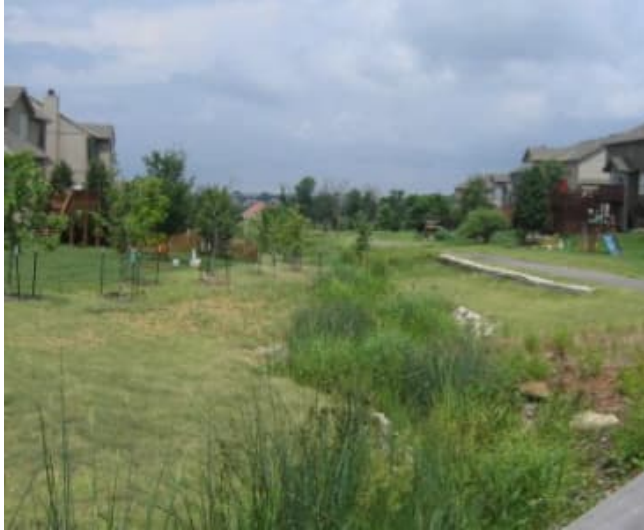
Figur 29. Nedsänkta planterade grönstråk som utformas så att de kan stå torra vid normalväder och svämmas över vid regnväder.
