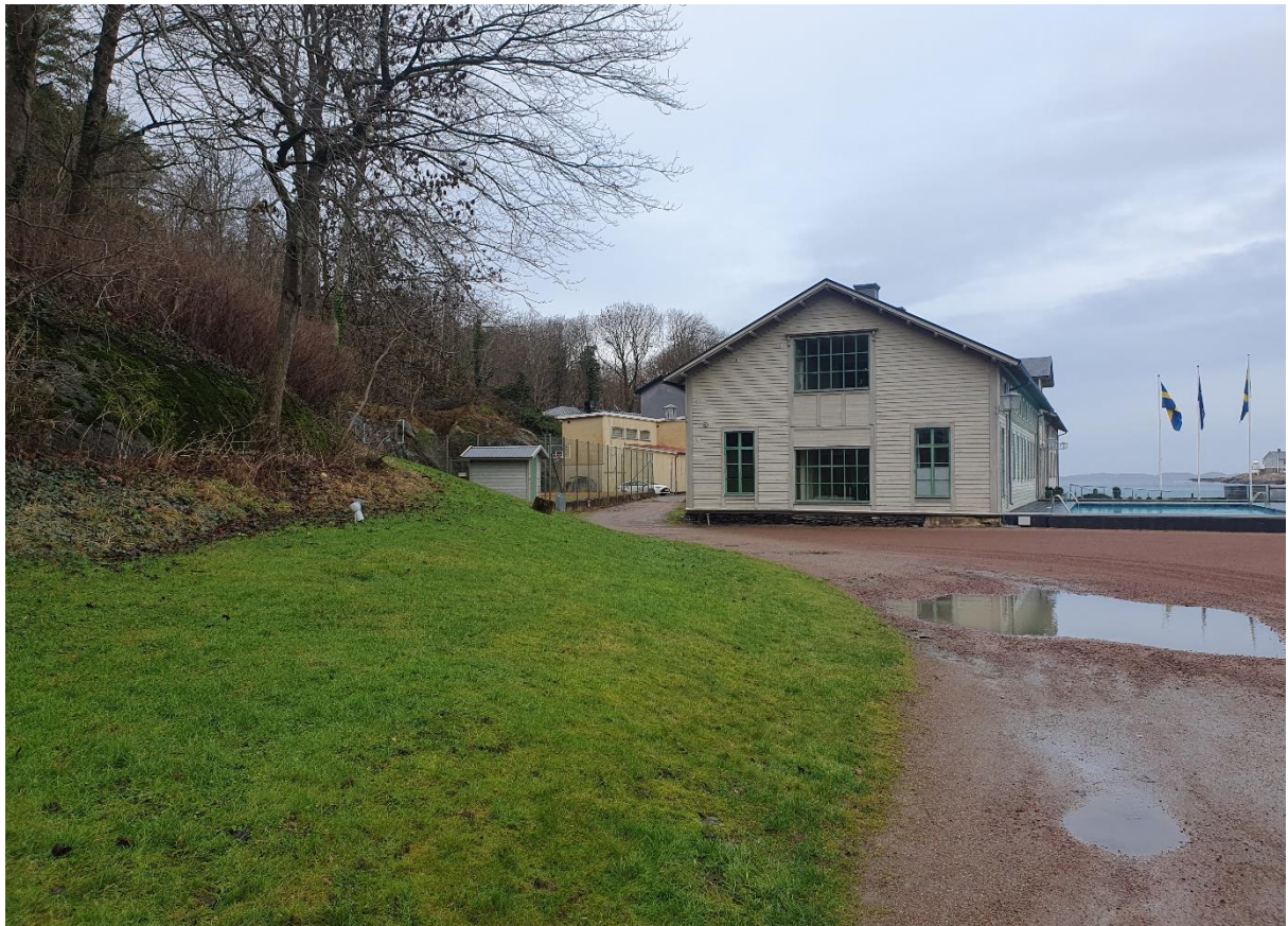
Vy mot Kurhotellet, tennisbanan och vattenverket som utgör den bebyggda gränsen mot naturområdet.
