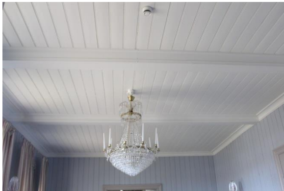
Tak i pärspontpanel och inklädda balkar – avväxlingar från 1979.
