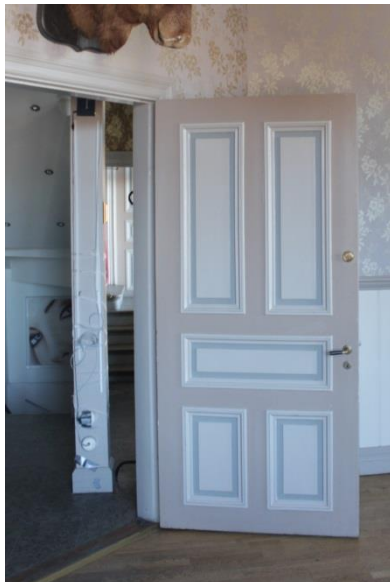
Spegeldörr mot entrén.
