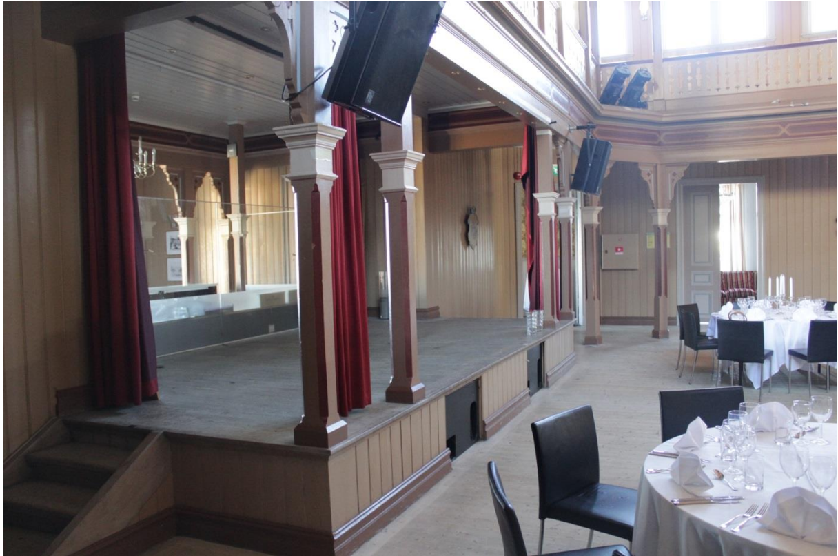
Scen vid salens ena kortsida. Denna scen hade ursprungligen dubbel våningshöjd och en trappa i framkanten. Nedre delen av pelarna är inbyggda i scenens främre del.
