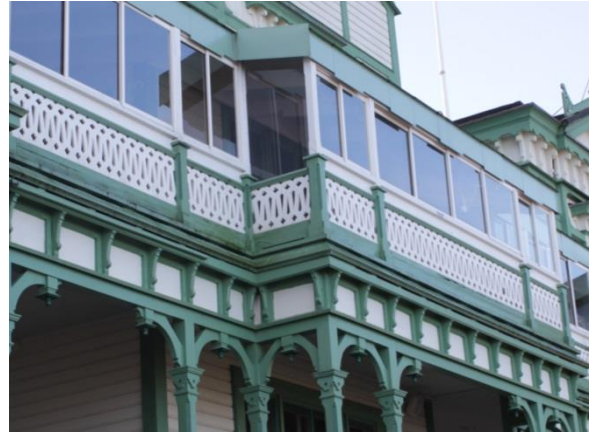
Inbyggd balkong på norra sidan.
