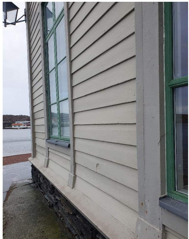
Samtliga fönster är utbytta.
