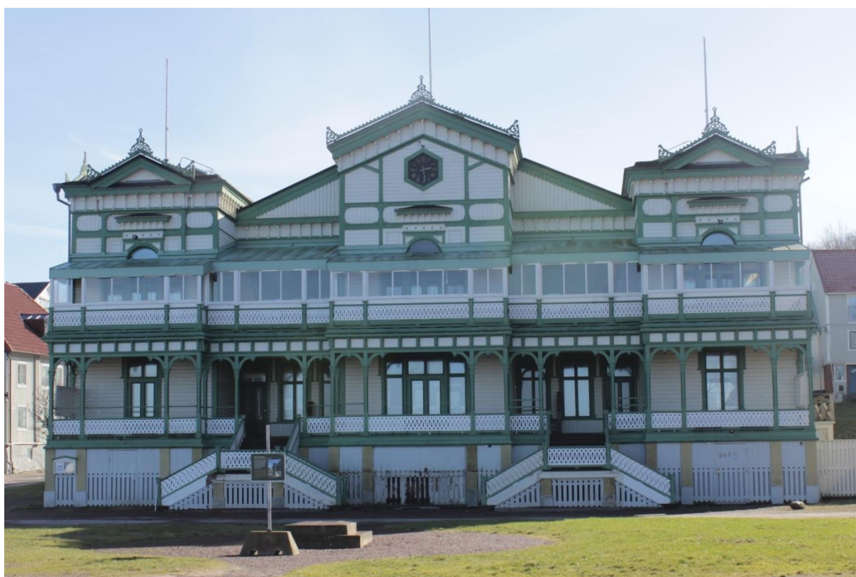
Fasad mot norr med veranda i två våningar och två trappor som leder upp till entréerna.
