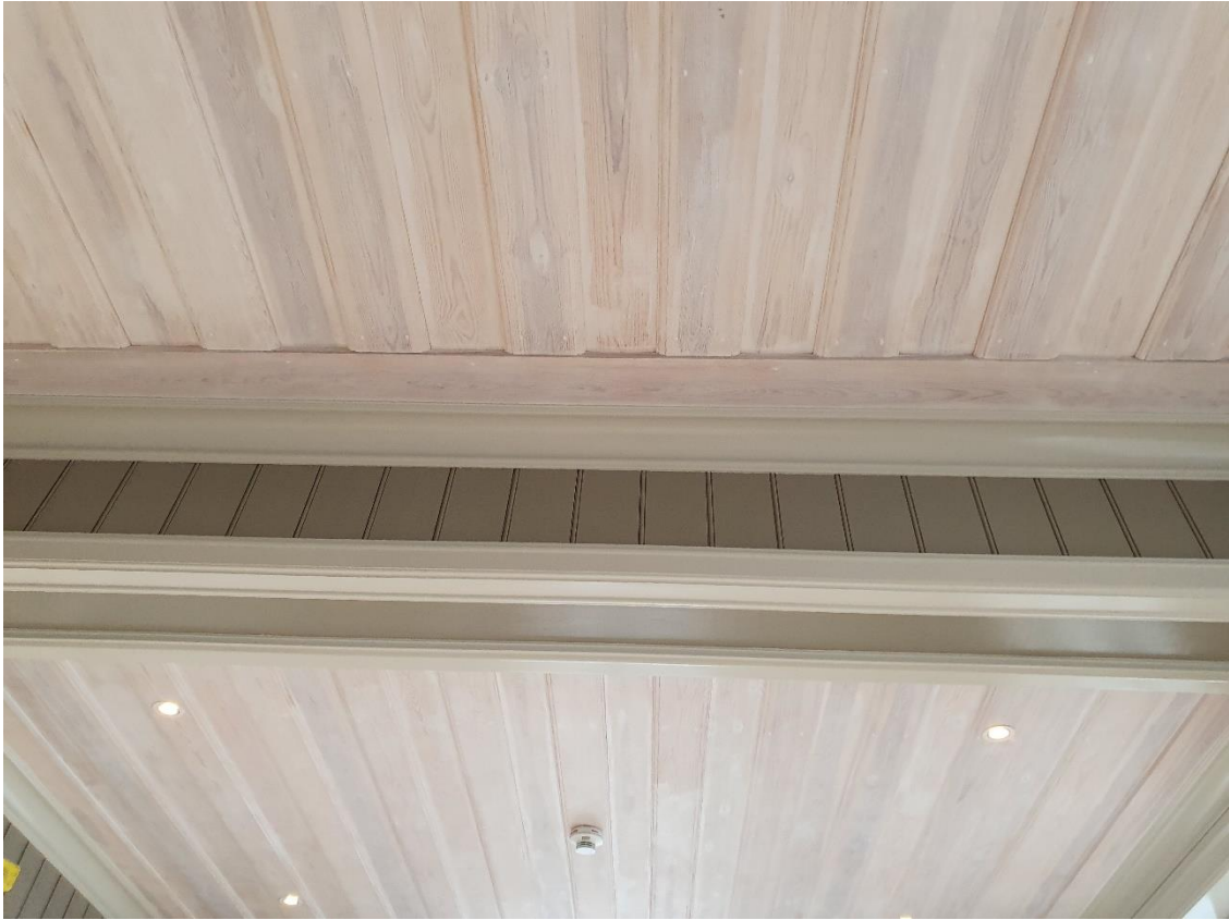
I hotellrummen är taken delvis sänkta för elinstallationer.
