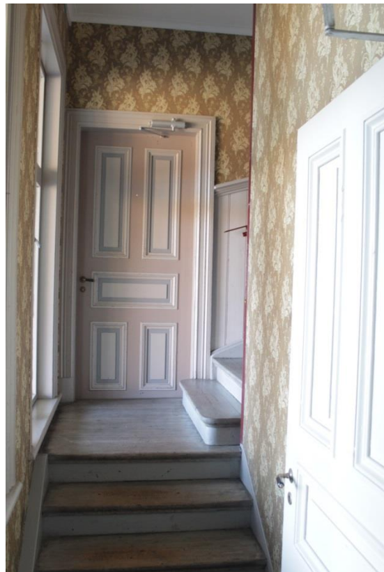
Trapphus i nordvästra hörnet. Trappan är i trä och har en målad bröstningspanel och tapet på övriga ytor.
