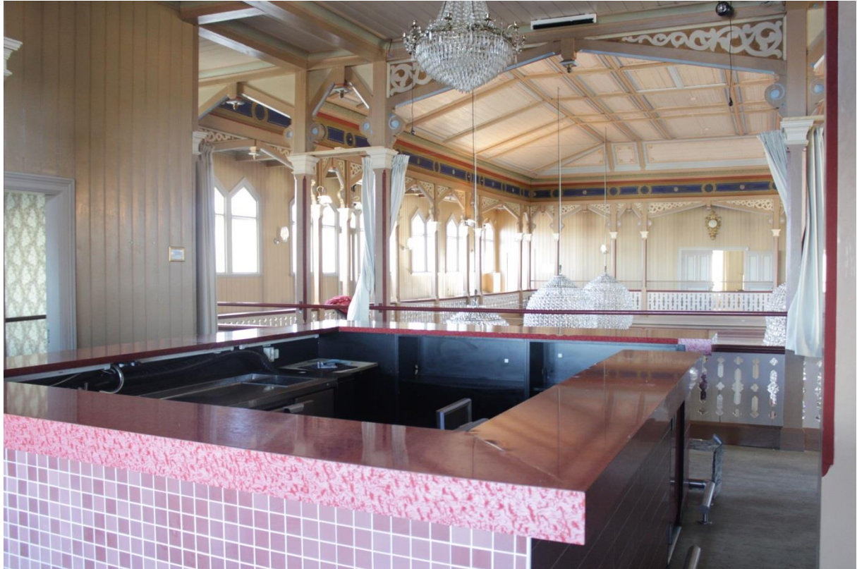
Baren på andra våningen utgör en del av det öppna rummet. Där baren står var ursprungligen inget bjälklag utan öppet mot nedanförliggande scen.
