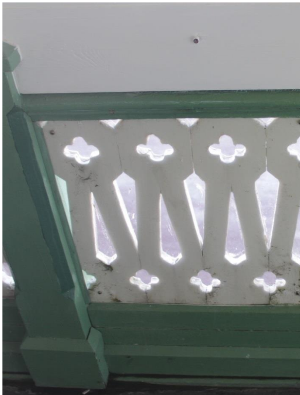
På insidan av räcket sitter plastskivor som vindskydd.
