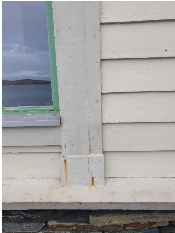
Panel och foder är delvis original med ilagningar och utbytta delar lika original.
