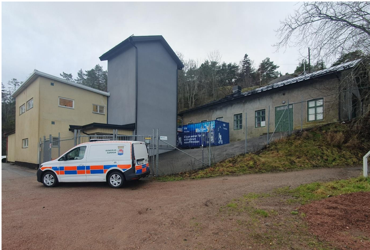
Byggnaderna mot berget ligger delvis i suterräng. Det spritputsade gamla elverket har en välbevarad exteriör.
