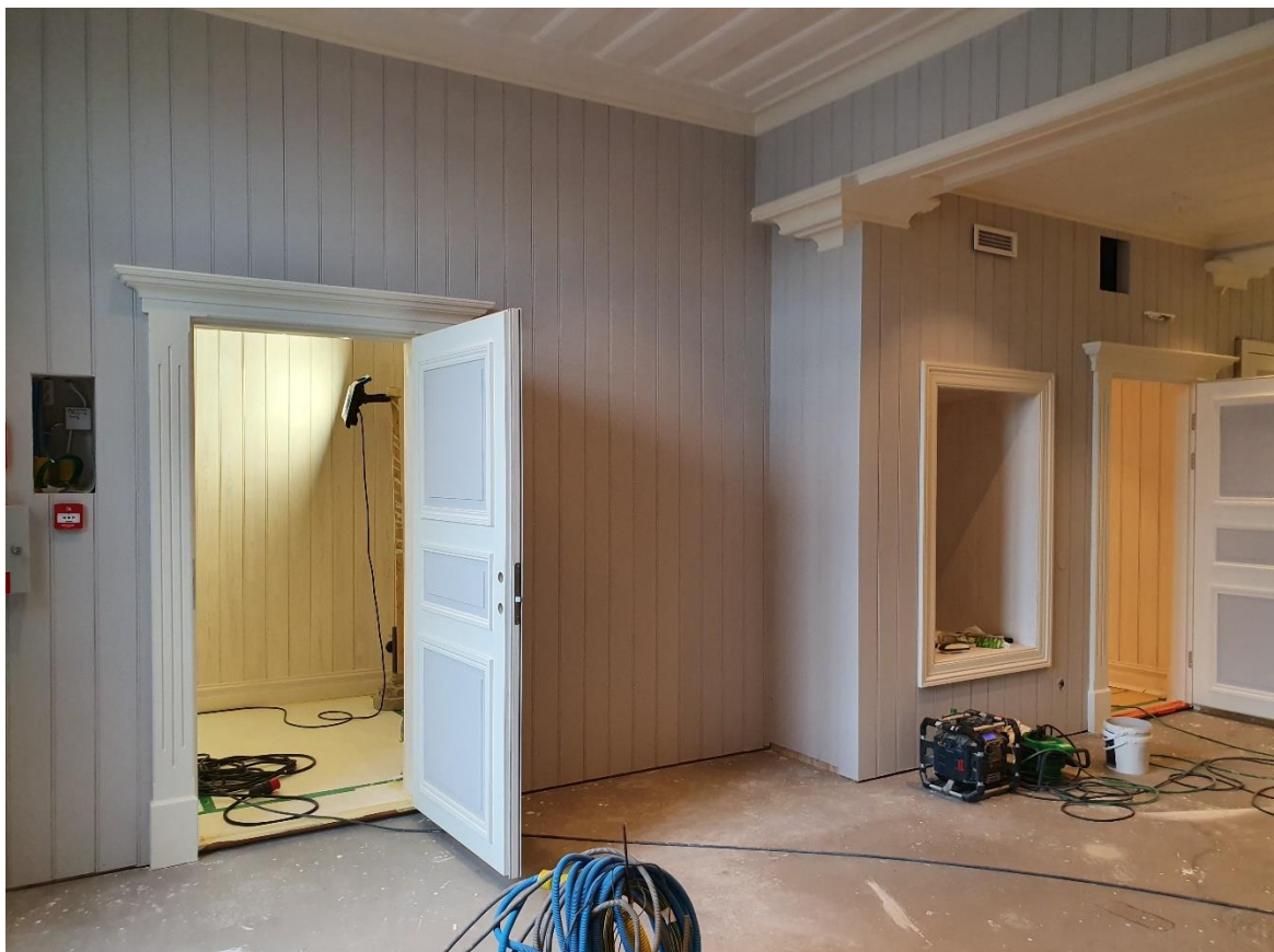
Nya snickerier och paneler på väggar och i tak.
