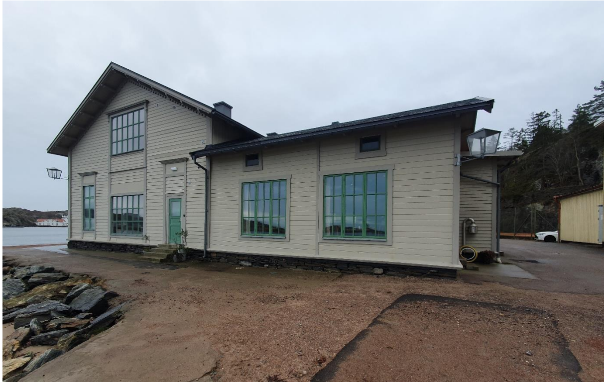
Den tvärställda byggnadskroppen närmast i bild tillbyggdes på 1890-talet. Gavelfasaden har överlag ursprunglig utformning, men det högra fönstret har bytts ut mot en dörr.
