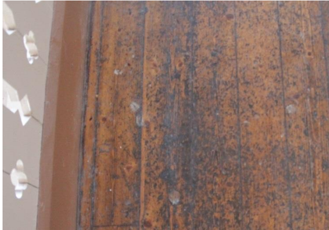
Brädgolv i balkong.
