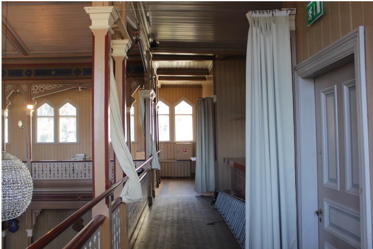
Balkongen hänger samman med intilliggande rum. Här gick ursprungligen balkongen runt hörnet och scenen på första våningen hade dubbel våningshöjd.
