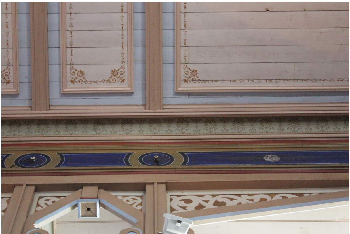
Taket har en slät panel indelad i fält genom ett listverk. Fälten är dekorerade med ett schablonmåleri.
