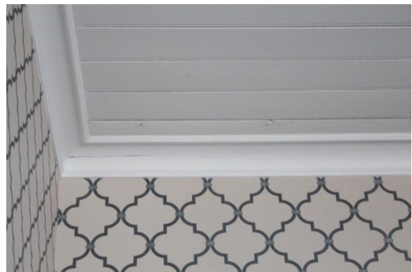
Tak med pärspontpanel och en kraftig hålkälslist.
