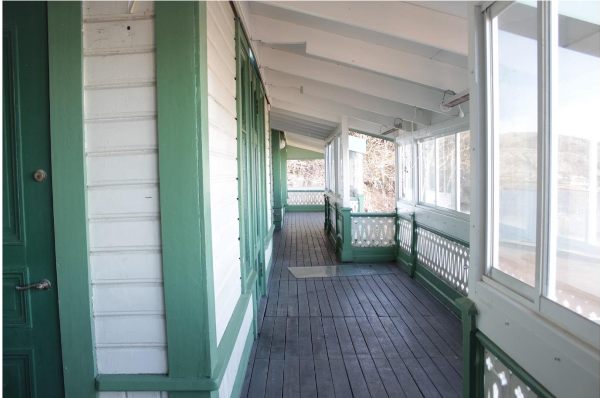
Balkongen är inbyggd med ett senare tillkommet tak och fönsterpartier i aluminium som vilar på balkongräcket.
