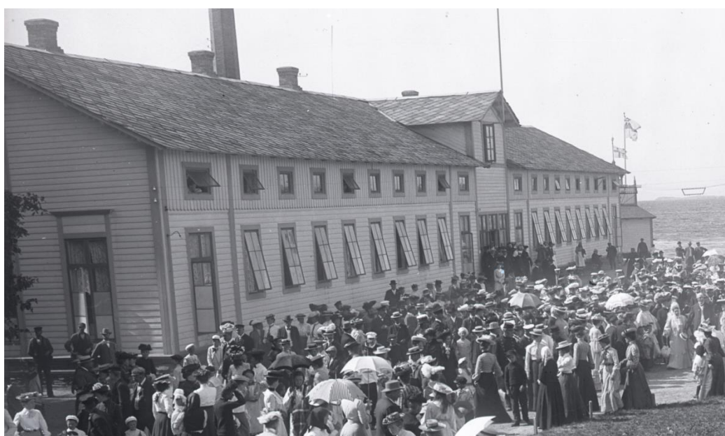
Varmbadhuset omkring 1900 med ursprungliga överkantshängda vädringsfönster och skiffertäckt tak samt en hög murad skorsten. Foto Bohusläns museum.
