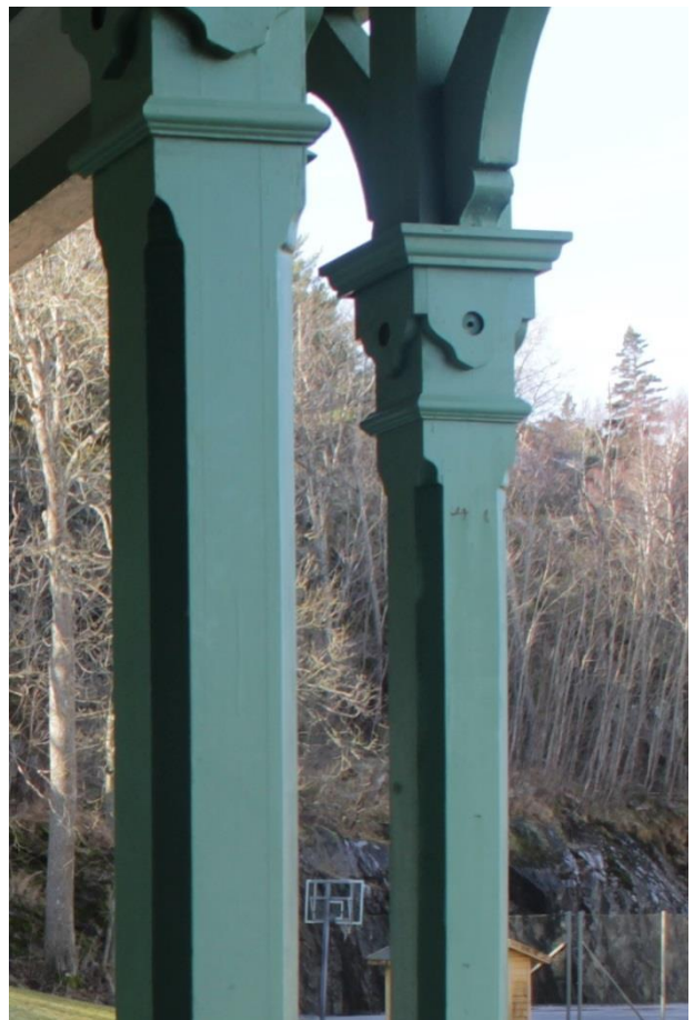
Pelare i trä med fasade kanter och kapital bär upp balkongen på utsirade konsoler.
