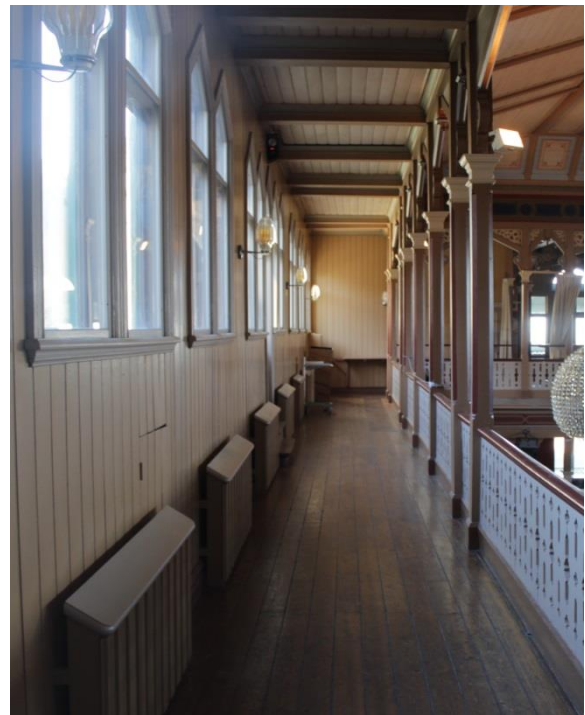
Vägg med pärlspontpanel och kopplade spetsbågiga tvåluftsfönster.
