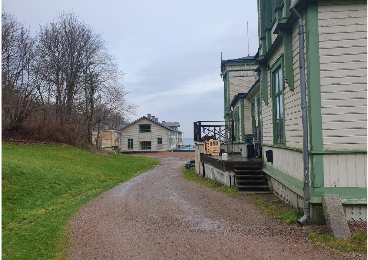
Befintligt utseende. Vägen breddas eventuellt och förses med ny markbeläggning.
