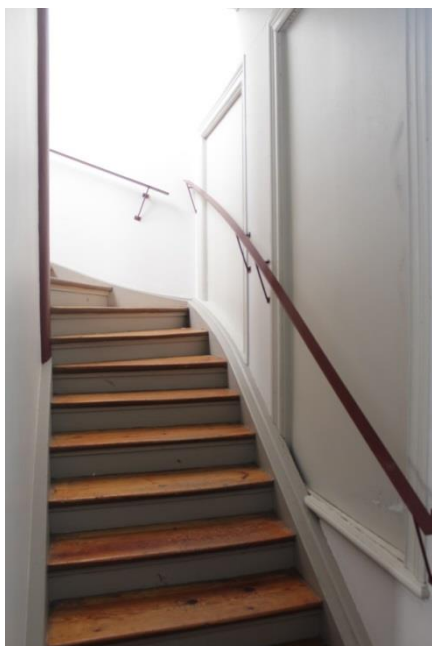
Trapphus mot sydväst.
