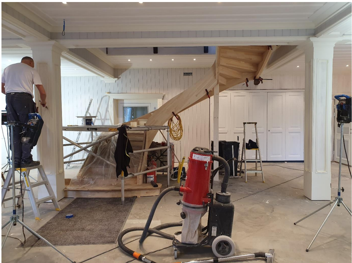
Foajén med justerad planlösning samt nya paneler och snickerier.
