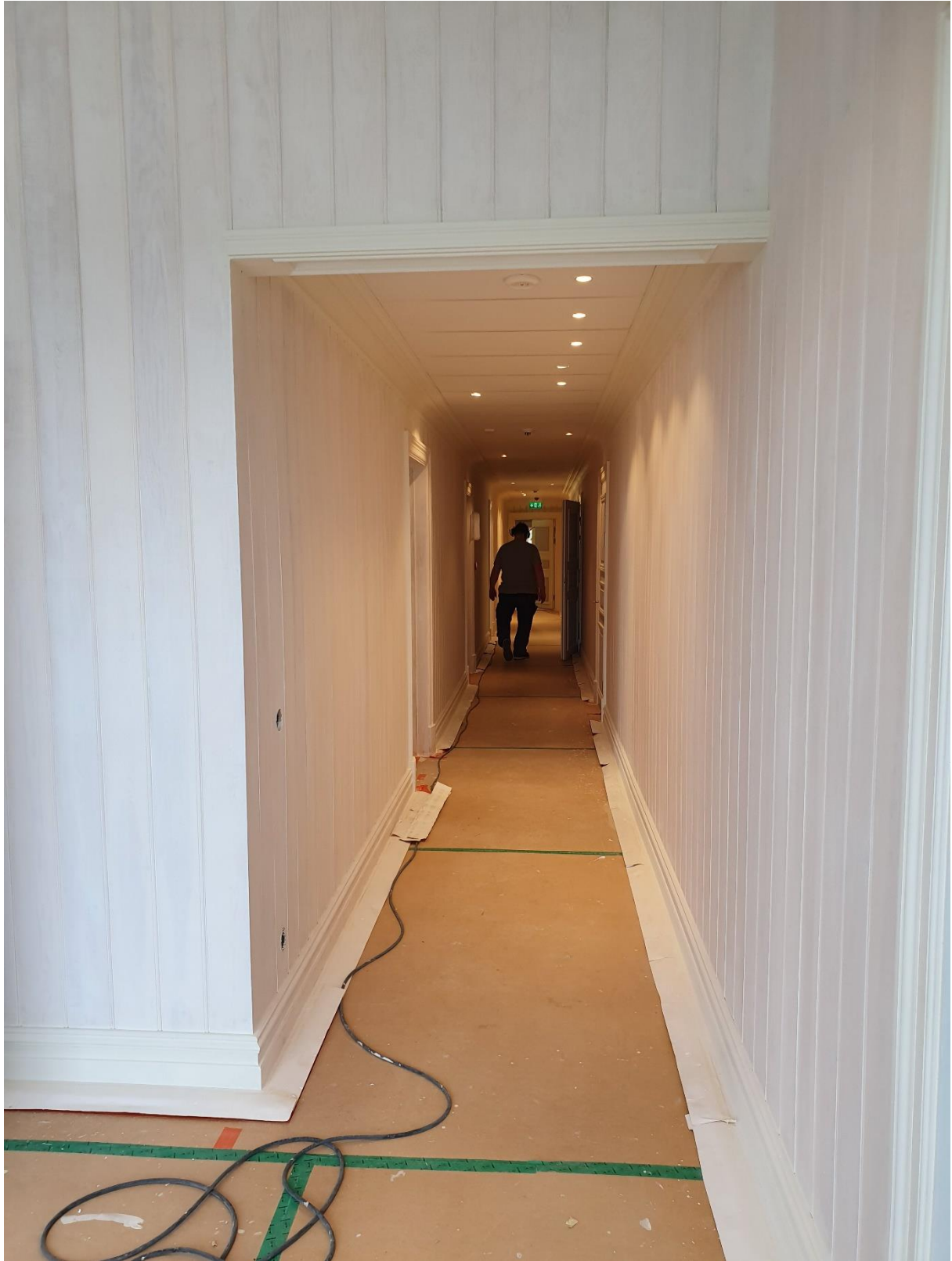
Ombyggd korridor med sänkt tak.
