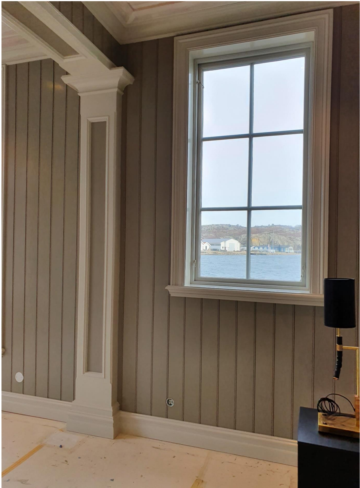
Hotellrummen har försetts med paneler och snickerier delvis lika original. Socklar och foder är liknande original medan pilastrarna har tillkommit som ett nytt motiv.
