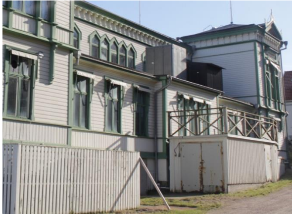
Fasaden mot väster har senare tillkommen altan och ventilationshuvar på taket.
