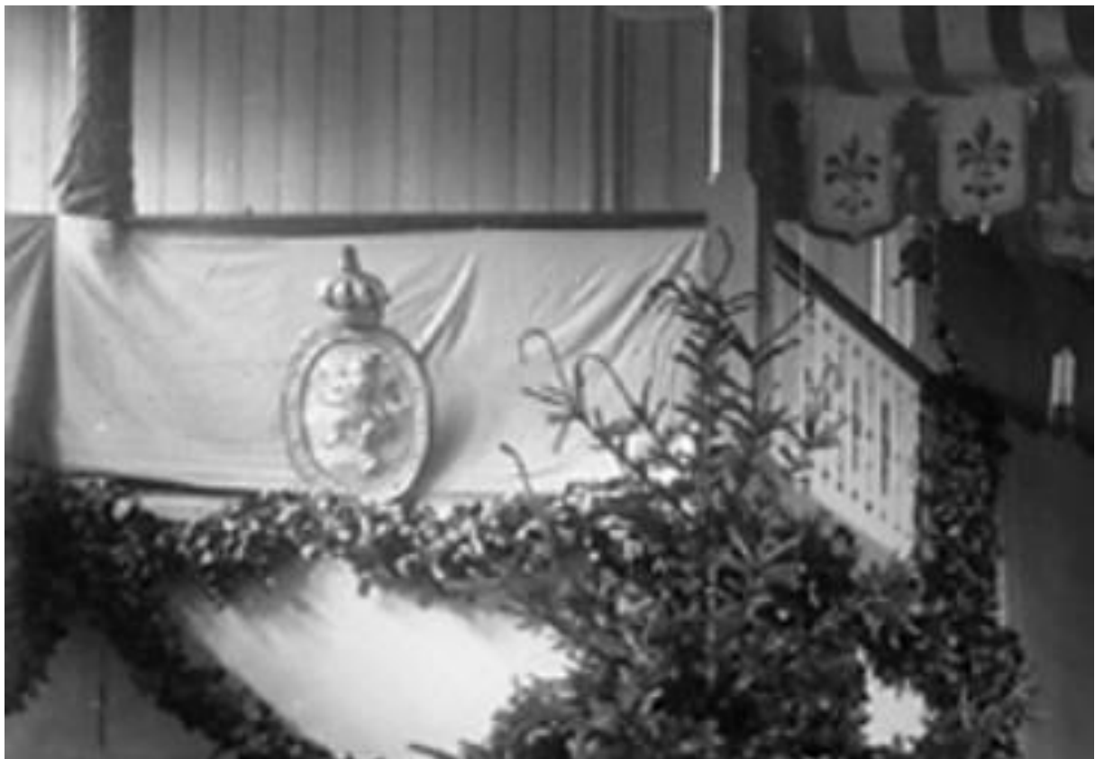
Detalj av fotot ovan visar balkongens dåvarande utsträckning. Här byggdes sedermera ett nytt bjälklag och balkongerna byggdes samman.
