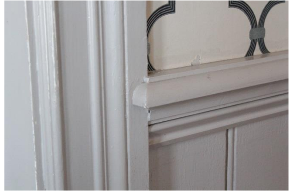
Profilerat dörrfoder och bröstningslist.
