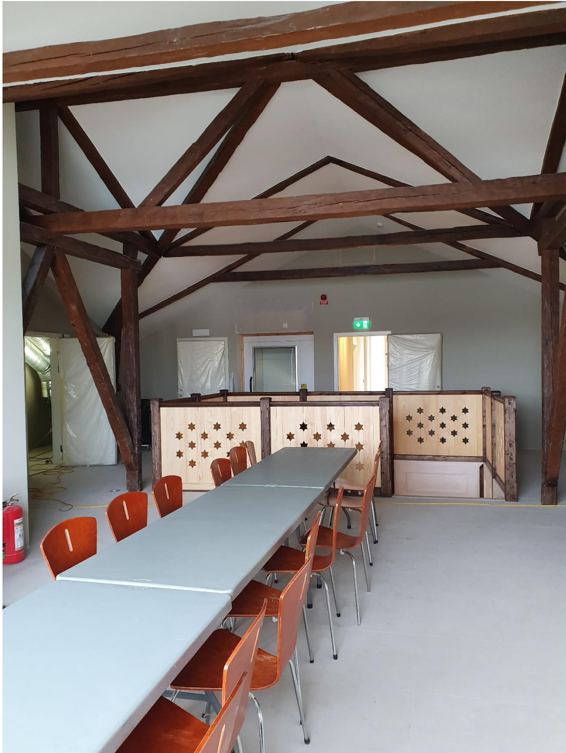
Rummet vid frontespisen och trappan till foajén med originaltakstolar.
