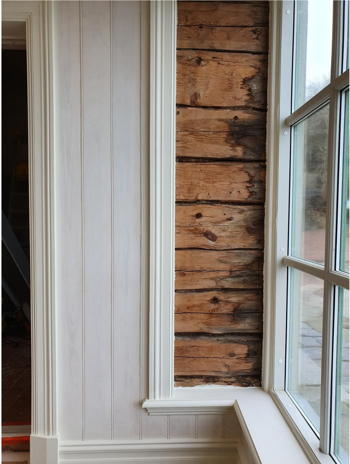
Vid gavlarna finns korridorens ursprungliga rumsbredd kvar. På bilden syns en bit frilagd timmerstomme.
