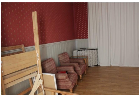
Hörnrum med parkettgolv, bröstningspanel och tapet.
