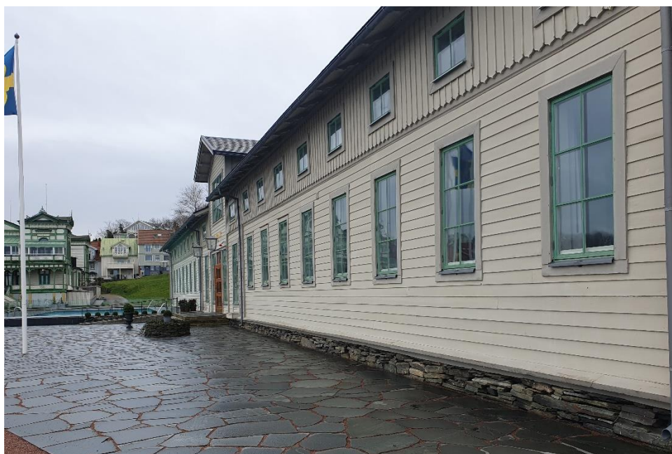
Fasaden är klädd med liggande och stående panel.
