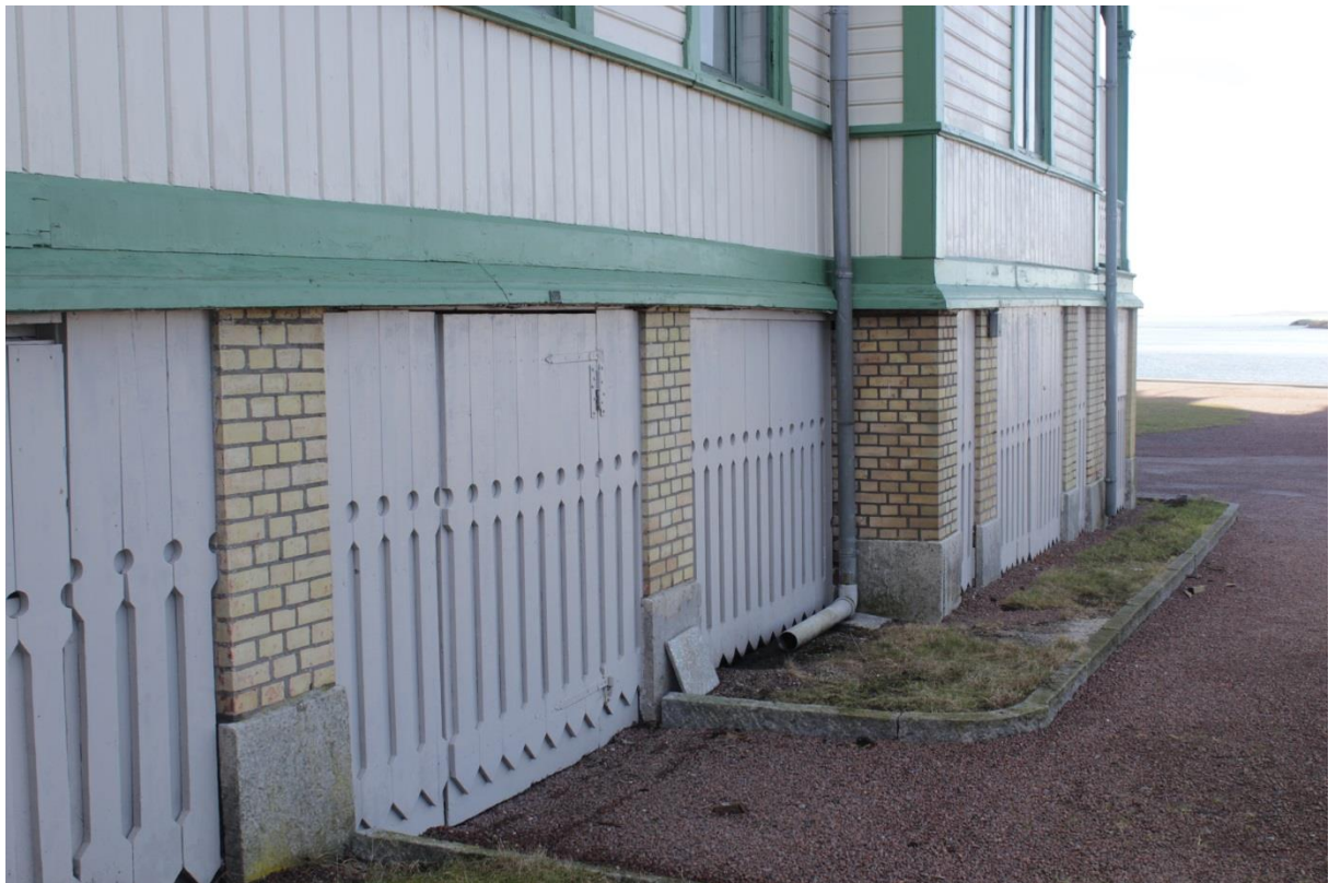
Förhöjd källarvåning med pelare i gult tegel och sockel i kalksten. Mellan pelarna finns en gråmålad panel med figursågade brädor.
