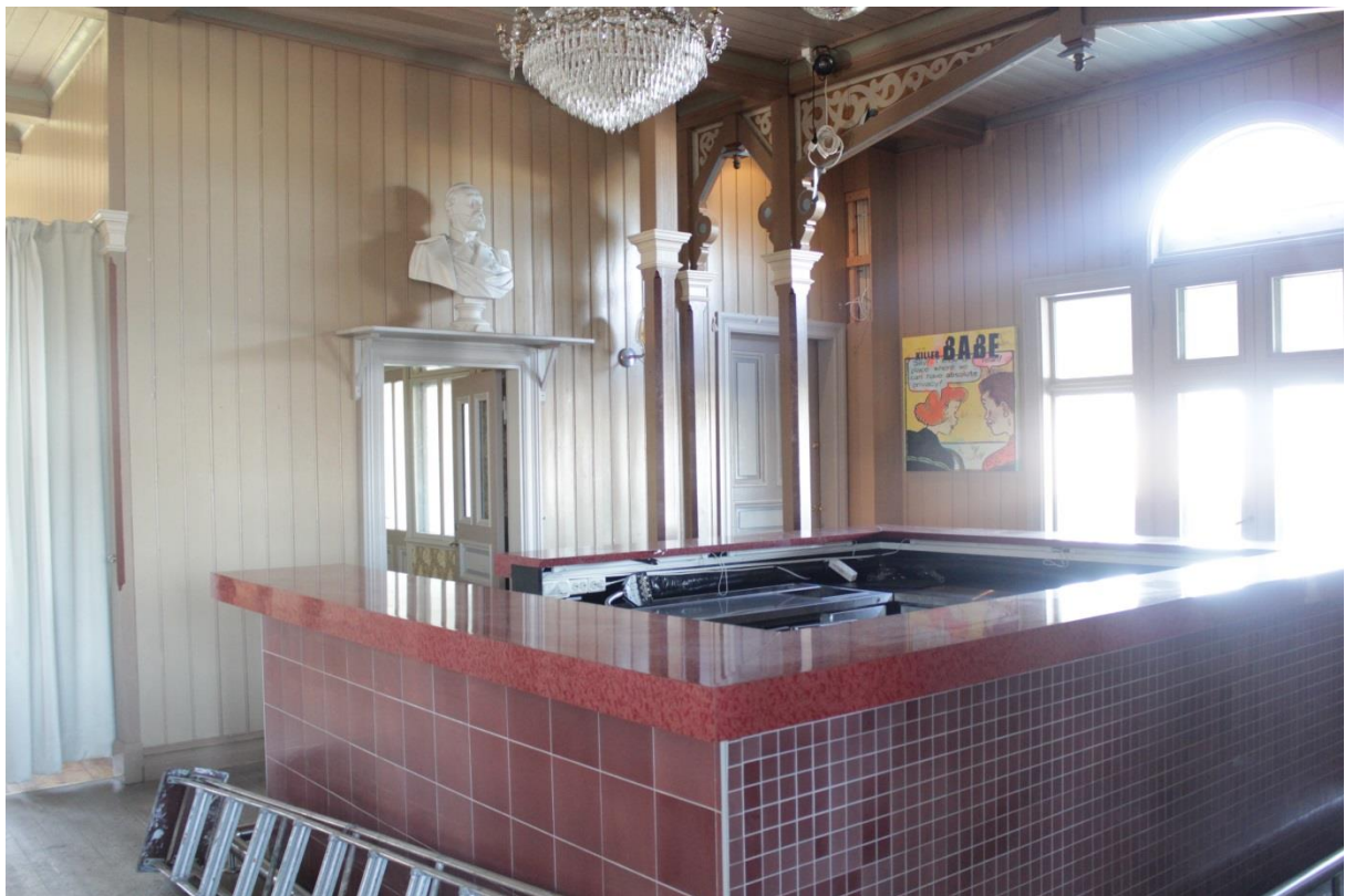
Rummet har brädgolv, pärlspontpanel och pelare i trä lika övriga delen av stora salen. En fönsterdörr leder ut till verandan. Pelarnas läge visar på balkongens tidigare utsträckning.
