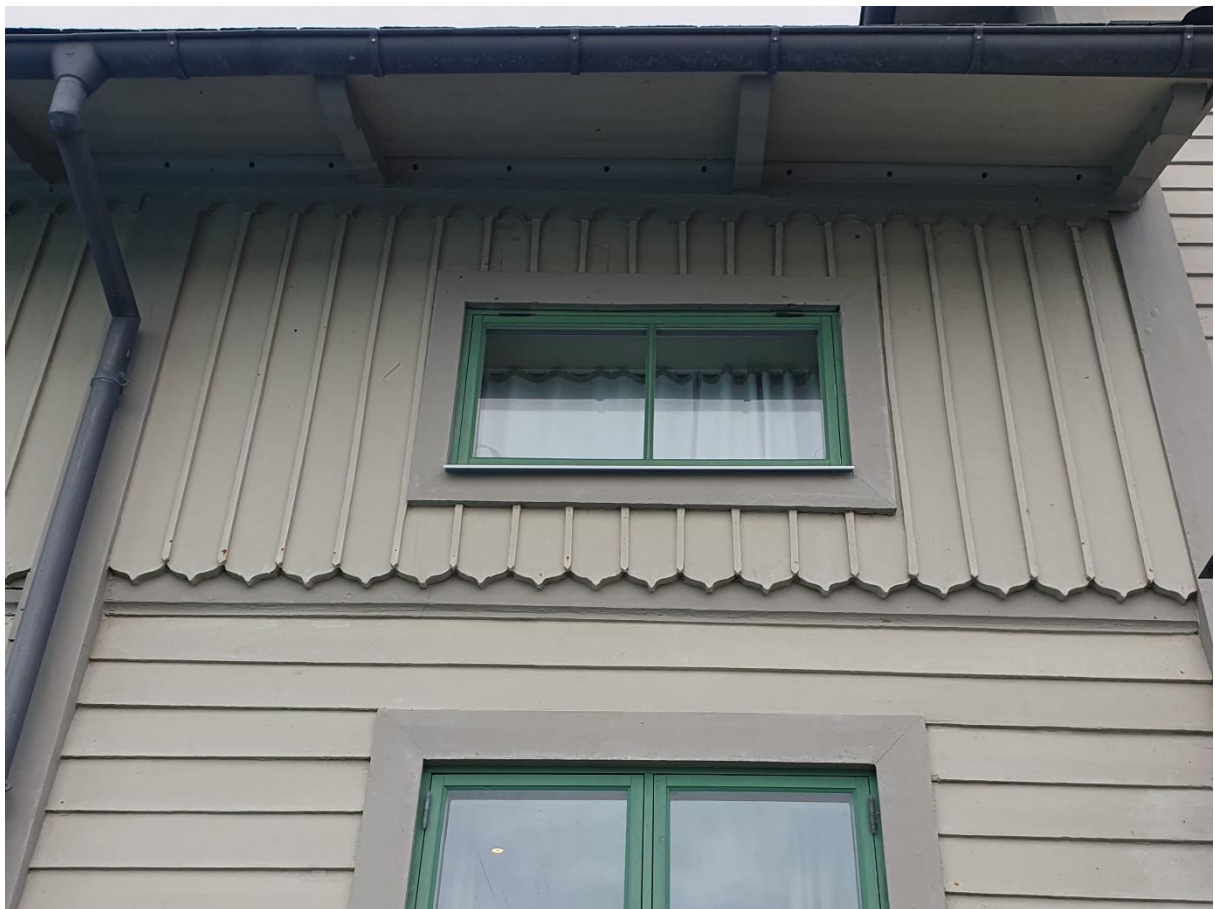
Fasaden har fjällpanel i nedervåningen och stående panel med smala locklister i övervåningen. Nederdelen av den stående panelen är profilsågad.
