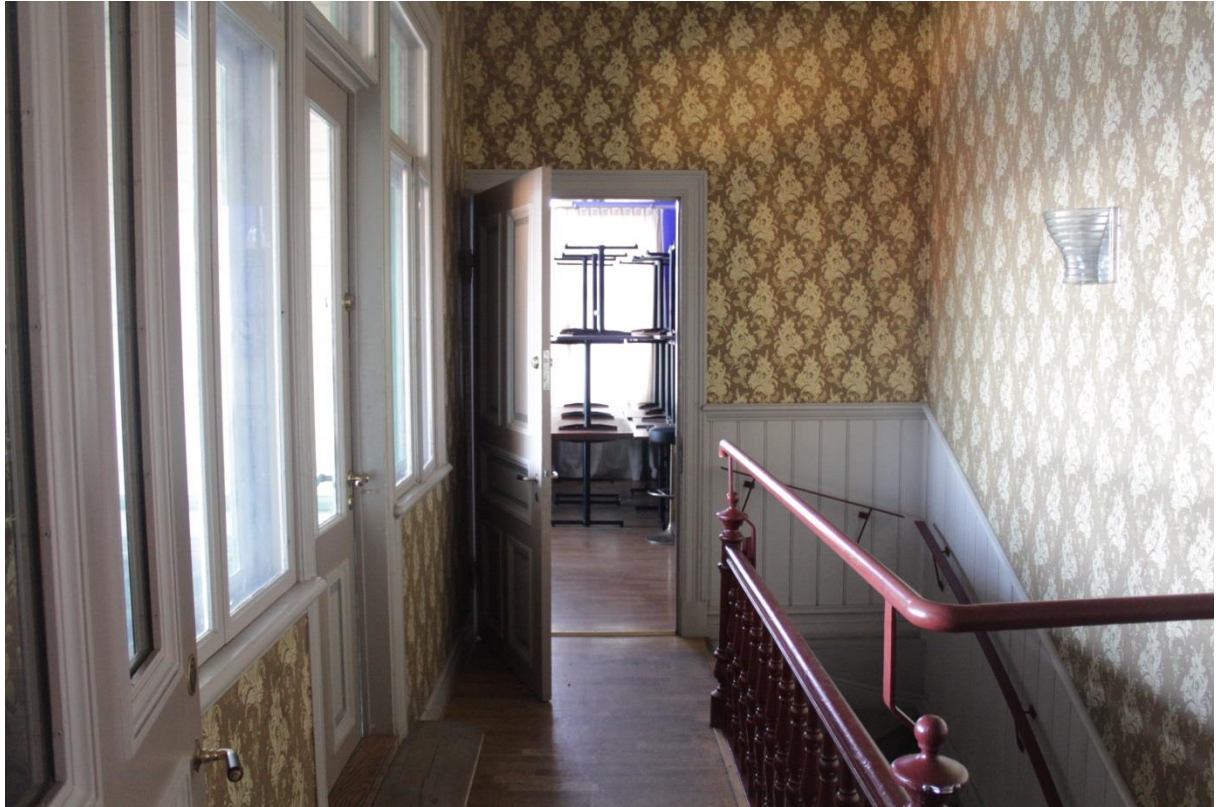
Övre delen av trapphuset mot nordöst med trägolv, bröstning i pärlspont samt tapet.
