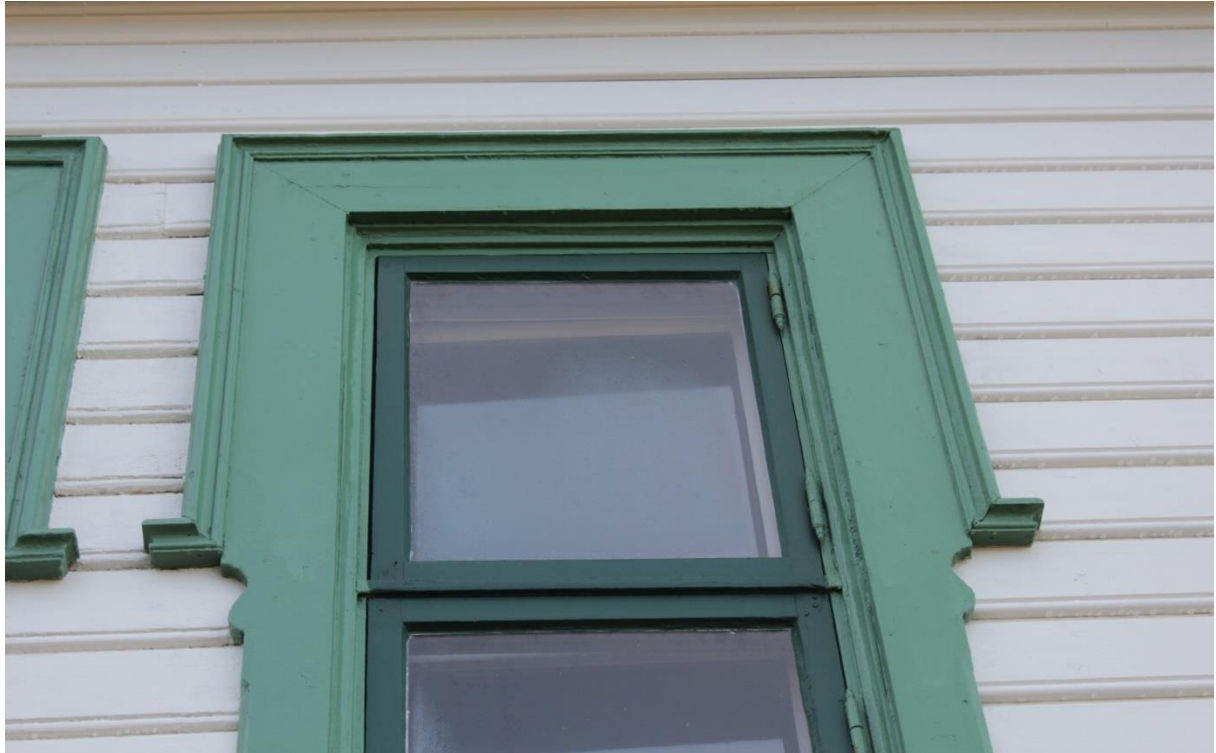
Figursågat foder med en profilerad list som ramar in fönstrets överdel.
