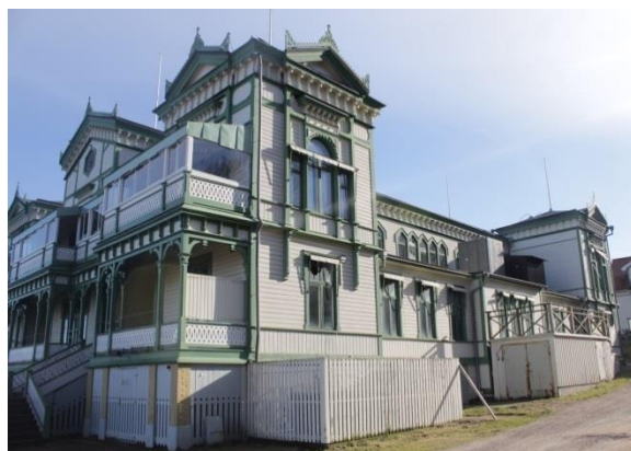
Fasad mot väster med senare tillbyggd altan och fläktaggregat på taket.
