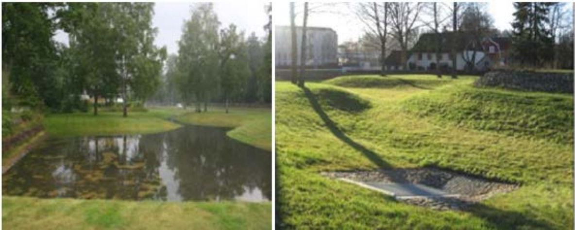
Bild 28; exempel på dagvattendammar i Växjö under torrt och vått väder (SWECO, 2016)
