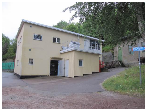
Vattenverket, före tillbyggnad på norrsidan
