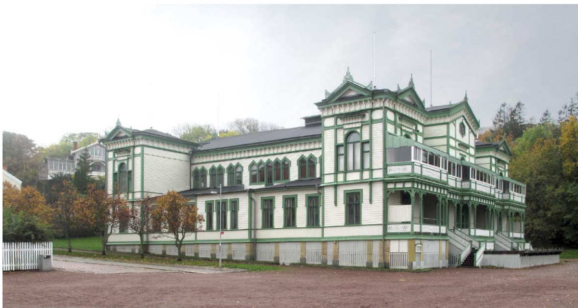
Societetshuset. Befintligt utseende, fasad mot öster
