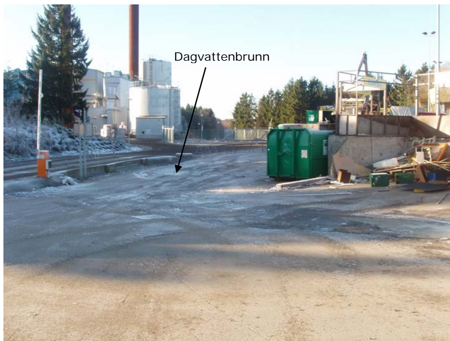
Bild 4 Vy över lågpunkt och dagvattenbrunnen inom området
