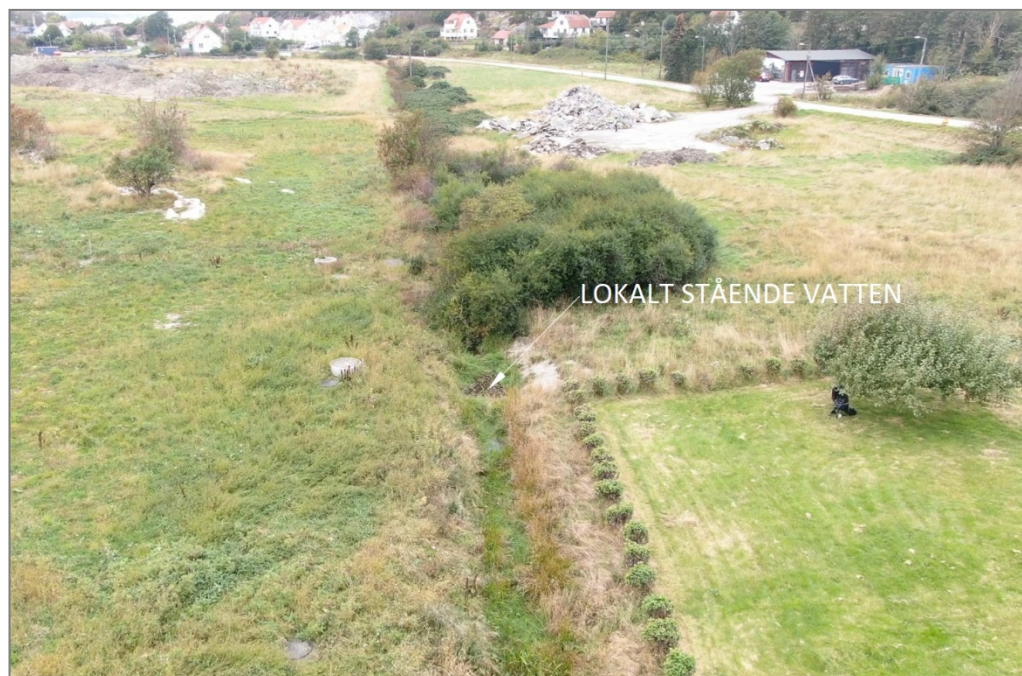
Figur 3. Befintligt dike (2019) i västlig riktning mot recipienten.
