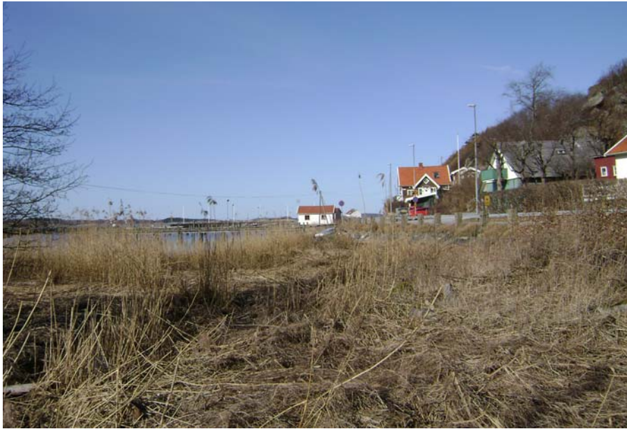
Figur 13 Huvuddikets utlopp vid småbåtshamnen i Tjuvkil
