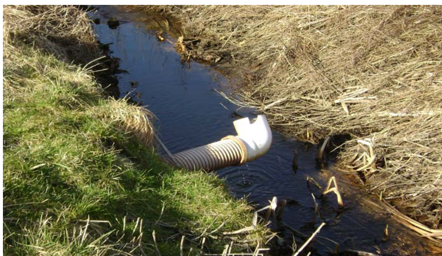
Figur 4 Utlopp vid nuvarande avloppsreningsverk för VA-område 5 i Tjuvkil
