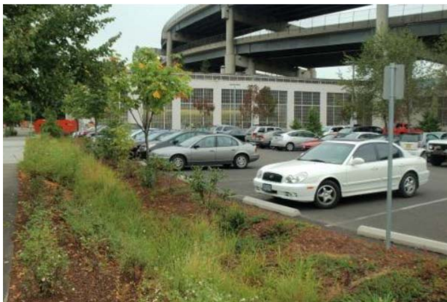
Figur 35 Exempel på svackdike för parkeringsdagvatten
