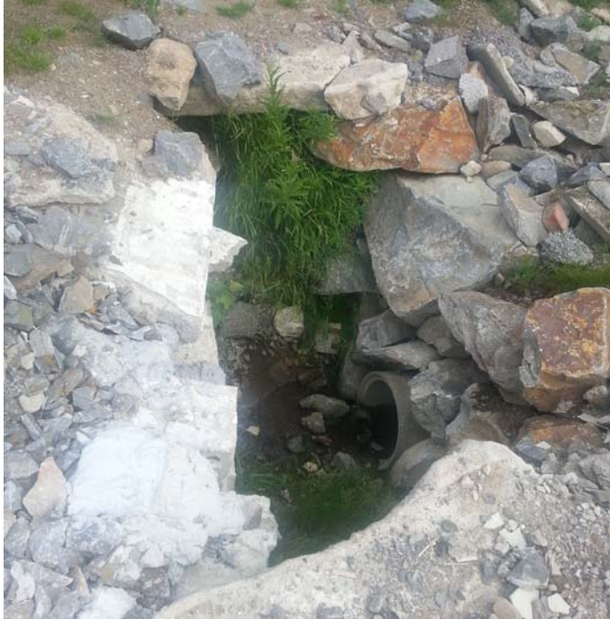
Figur 17. Uppsamlingsgrop med en 400 mm utgående betongtrumma.
