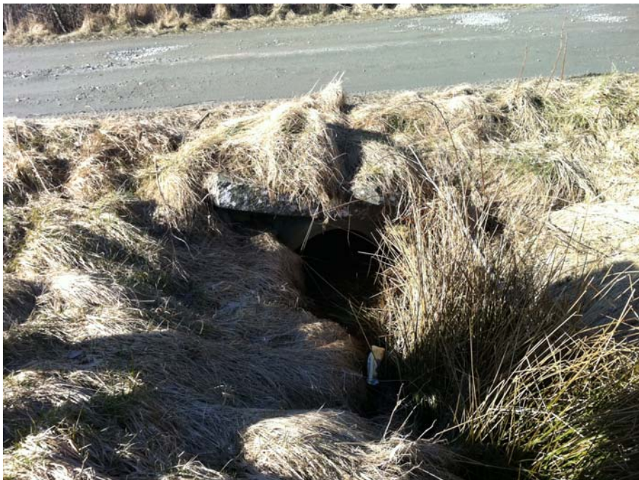
Figur 15 Ø 800 mm trumma under grusväg för huvuddike
