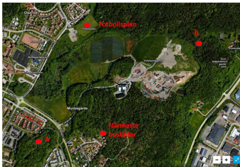
Specifika punkter kring fjärrvärmeverket
