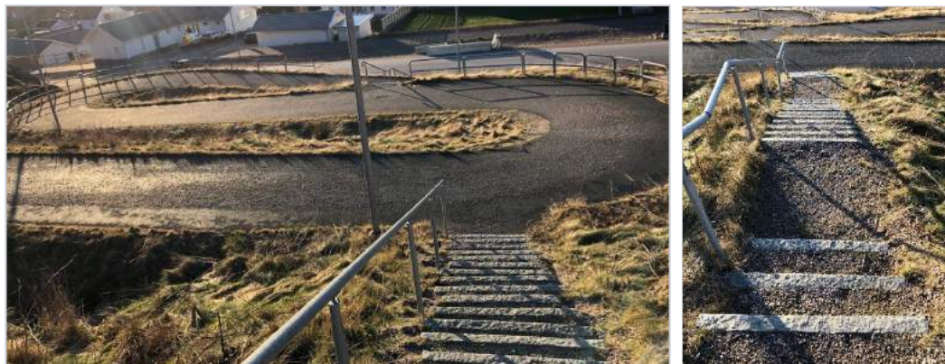
Figur 11. Gång- och cykelväg utformad som serpentinväg, inklusive trappor för ökad genhet för gående.
