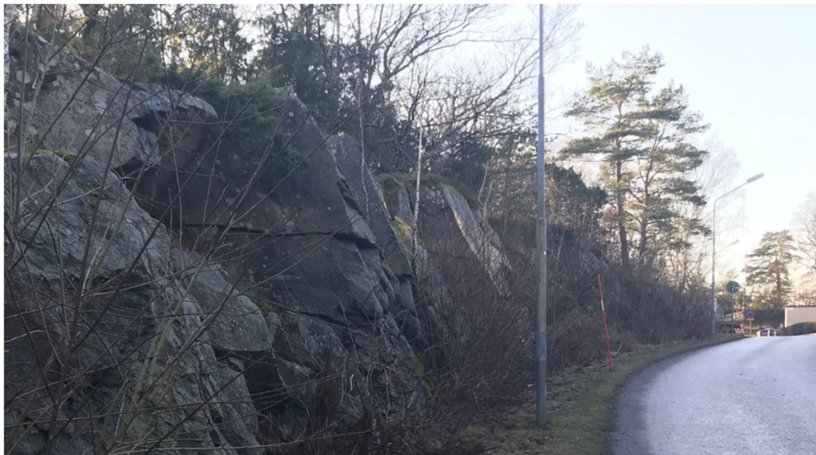
Figur 9. Foto mot syd-sydväst på skärning längs Hällebergsgatan. Skärningens lutning mot nordväst följer bergets brantstående naturliga strukturer.
