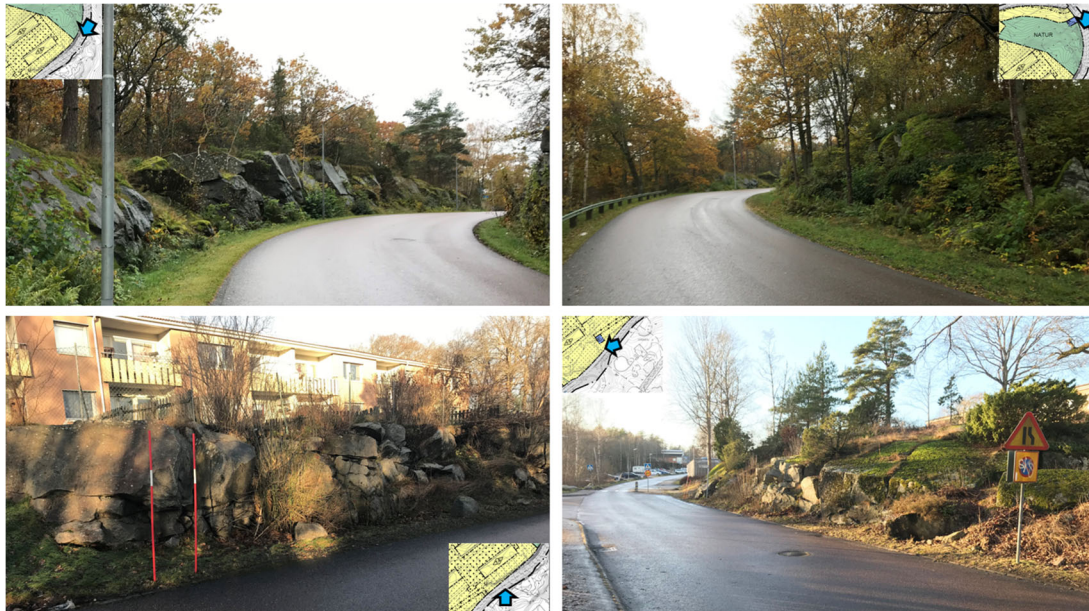
Figur 12. Skärningar längs Hällebergsvägen i Delområde 1. Slänterna har förhöjd uppsprickning p.g.a. sprängskador.
