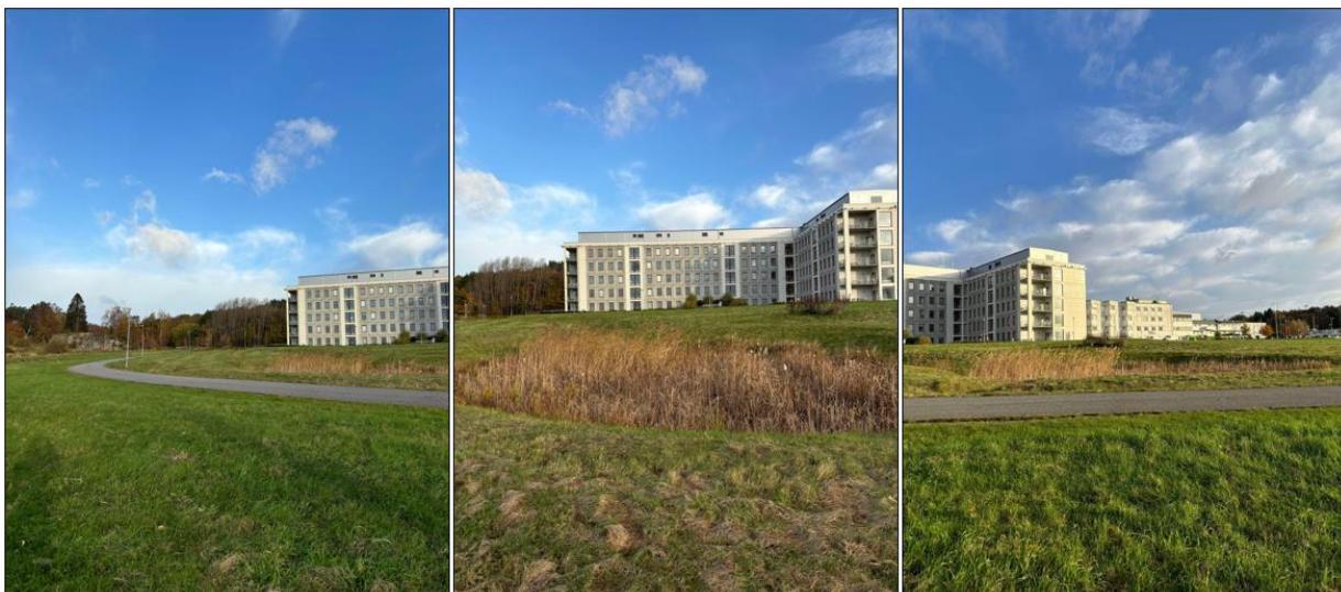
Figur 7-2 – Översiktsbild av dammen belägen norr om befintlig cykelväg.
