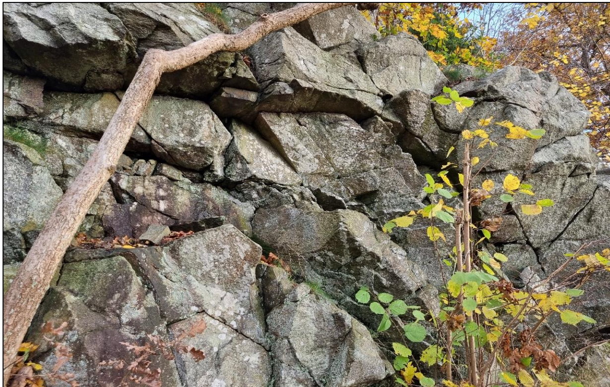
Figur 7-4 – Översiktsbild över västra bergslänten. Berget är uppsprucket och vegetation klär delvist bergslänten.
