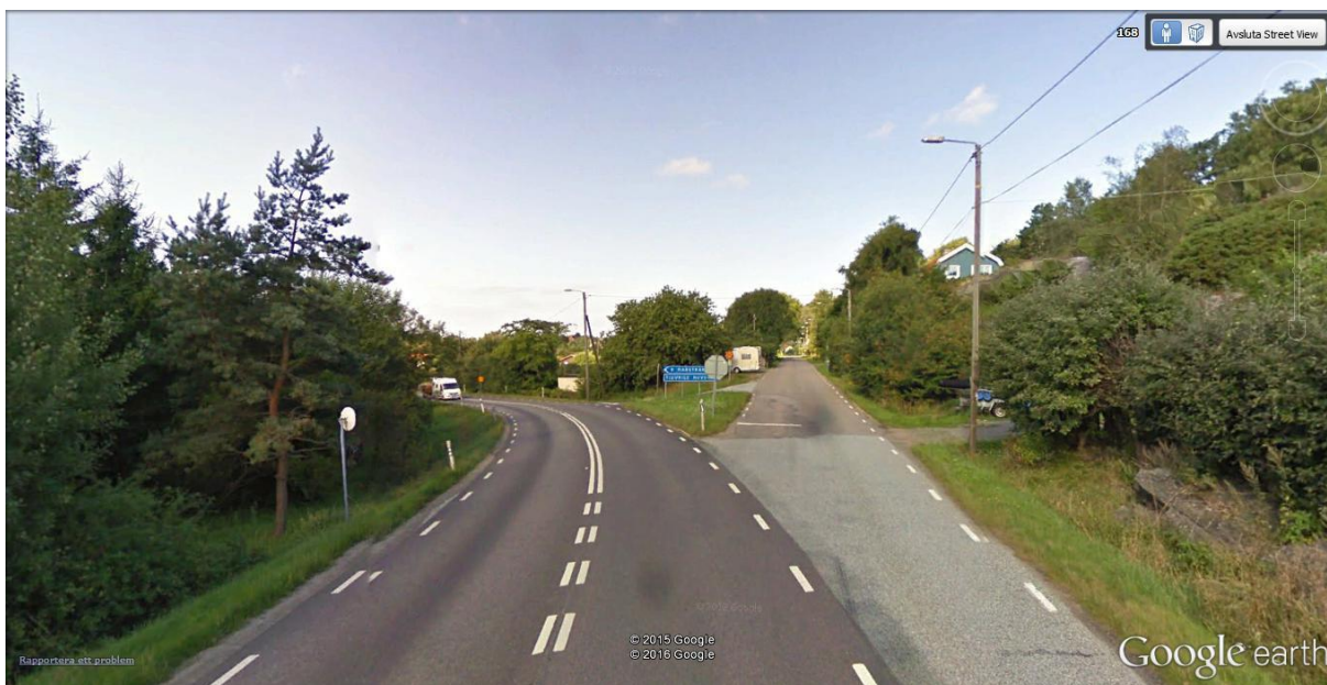
Figur X Tjuvkils vägskäl, en mindre trafiksäker anläggning som avses åtgärdas genom vägplanen. Den enkla geometrin bidrar dock till att vägen smälter in i omgivningen (Källa: Google Earth).
