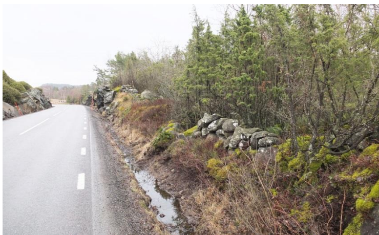
Stengärdesgårdar längs den västra delen av vägsträckan, är troligen samtida med vägen som invigdes 1940.
