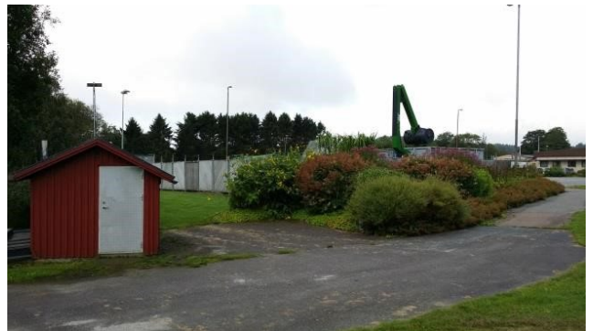
Befintlig pumpstation "Röda stugan" i nordöstra delen av planområdet.
