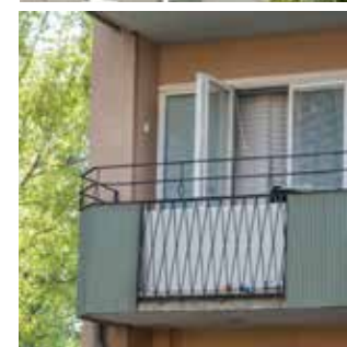
Front i vågkorrugerad plåt (sinusprofil), genombrutet smidesparti
