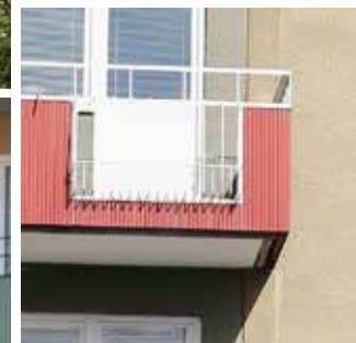
Front i vågkorrugerad plåt (sinusprofil), genombrutet smidesparti
