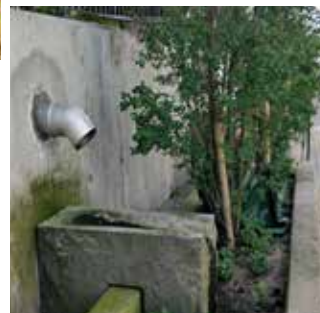
Dagvattenlösning integrerad i upphöjd innergård.
