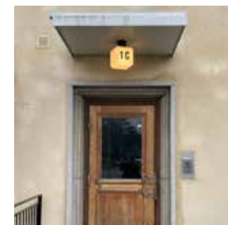
Enkelt utformad entré; skärmtak, lampkupa i glas, smal kant av natursten inramar dörr, elegant rundat dörrhandtag
