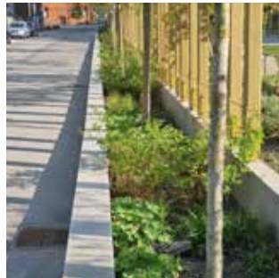
Dagvatten leds i plantering
