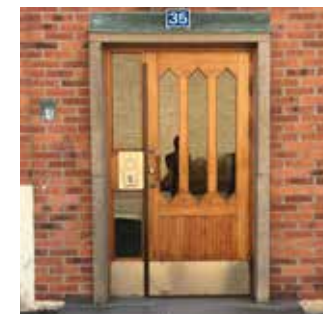
Entréparti i trä med inramning i natursten och dekorativa fönster i dörr
