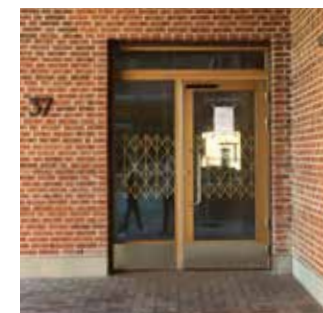
Ädelträinspererad kulör, tegel i ojämnt förband
