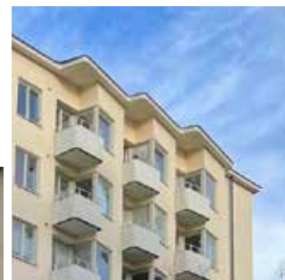
Balkonger; måttfulla i antal och djup och längd, delvis rundade, integrerade mot burspråk, fronter i vågkorrugerad plåt (småsinusprofil).
