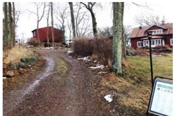
Bild 20. Uppfart till Spa-byggnaden, bostadshus till höger.
