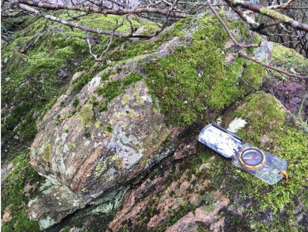
Figur 10. Plats 4 där blockutfall eventuellt kan ske.
