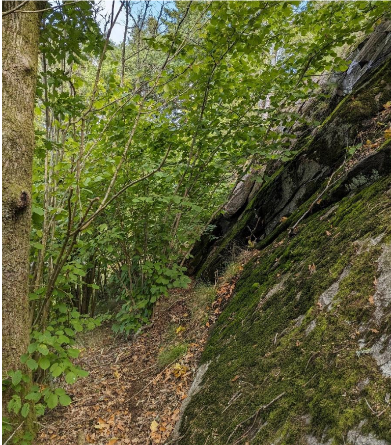
Figur 4.2. Skivig uppsprickning vid Spadvägen 14. Skivorna har bottenstöd idag men kan destabiliseras om schakt utförs under dem. Bild tagen norrut.
