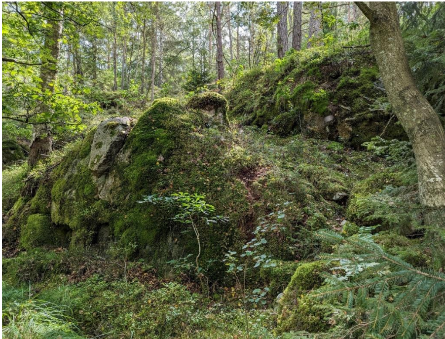
Figur 4.5. Blockuppsprucken bergslänt som reser sig i "trappsteg" uppåt. Längs släntfot utanför bildens högra sida finns en blockslänt som är stabil i dagsläget men blocken kan undermineras vid schakt under dem. Bild tagen mot sydöst.
