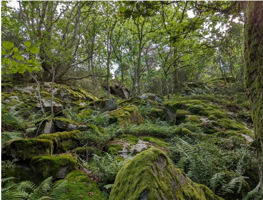
Figur 3.1.3. Exempel på blockslänt under bergslänt. Blocken vilar stabilt på underlaget men kan destabiliseras vid schakt i nederdelen av slänten. Bild tagen österut vid Settingsvägen.
