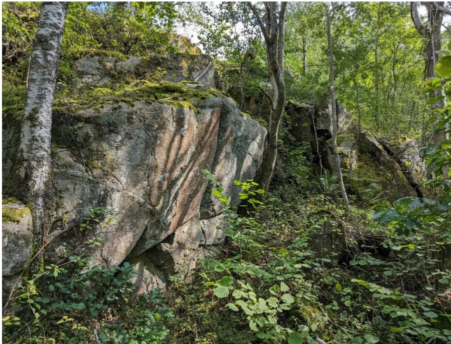
Figur 4.3. Liten rasbrant vid dammen i mitten av undersökningsområdet. Blocken är stabila idag men kan destabiliseras vid schakt under dem. Bild tagen mot öst.
