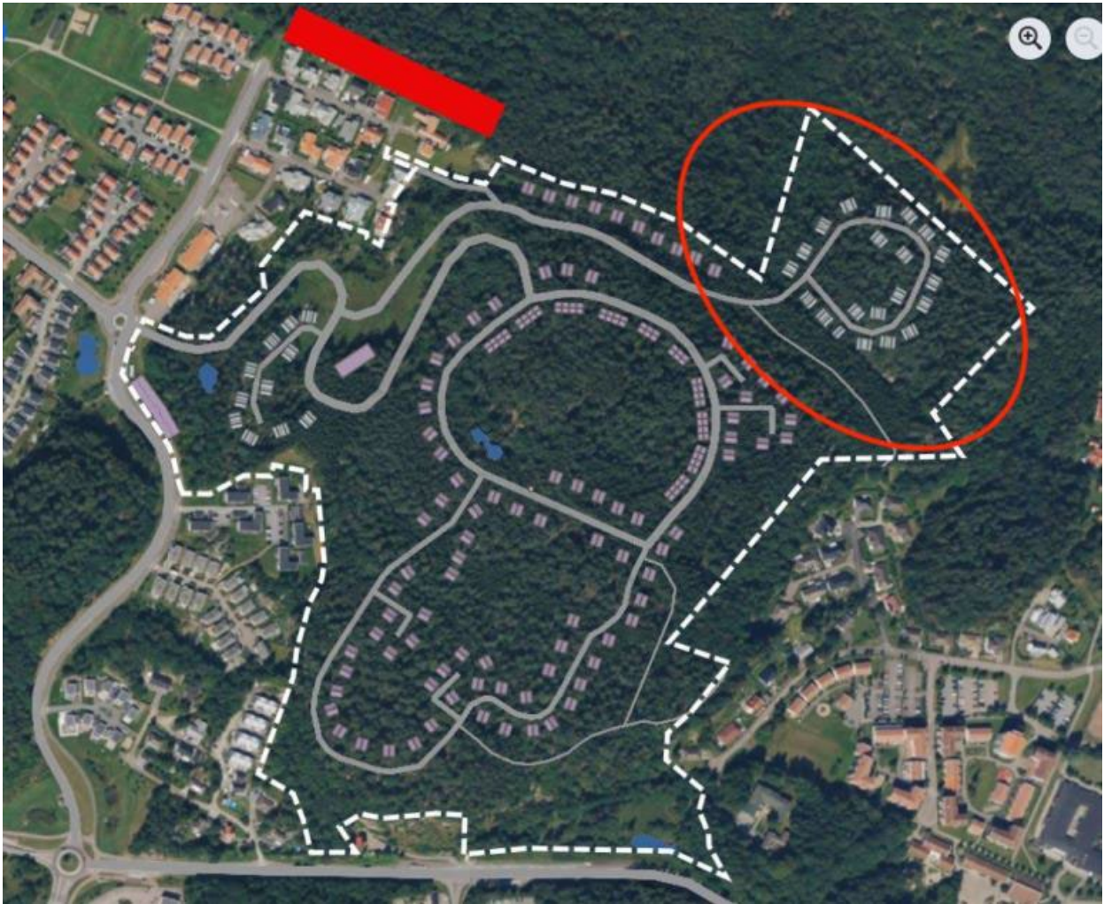
Figur 4. Byggnationerna med röd ring runt ligger precis intill den blockbrant som är av högt värde för groddjur. Större vattensalamander finns i vattendraget nedanför.
