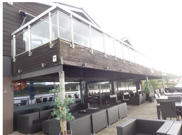
Figur 17. Alla altaner och balkonger runt om bygganden är av tryckimpregnerat virke.
