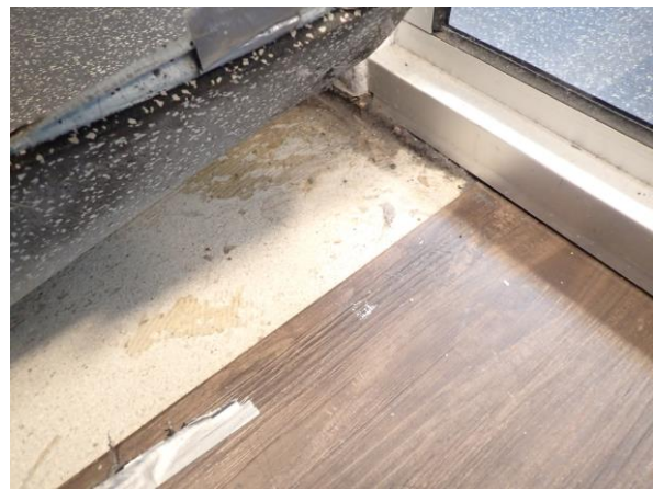
Figur 19. Under gym-mattor by 1 och 4 fanns endast rena betonggolv där kontroller kunde utföras.
