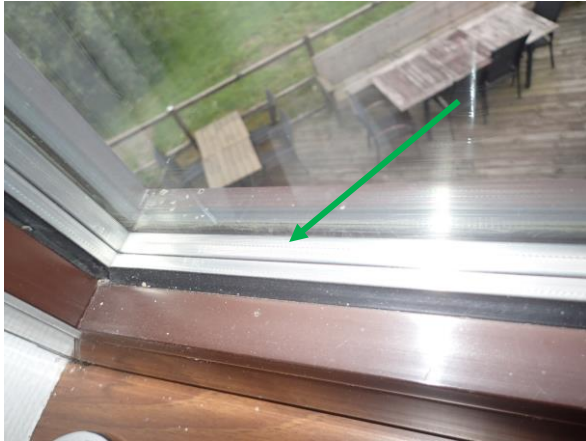
Figur 14. Isolerglas är från 1980-2000-tal utan misstanke om PCB.
