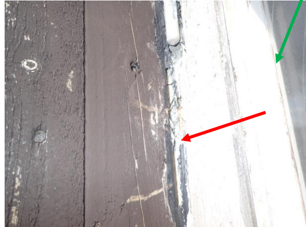
Figur 15. Prov kitt äldre träfönster by 5, ej asbest enligt analys. Röd pil visar placering internitskiva bakom träfasad.
