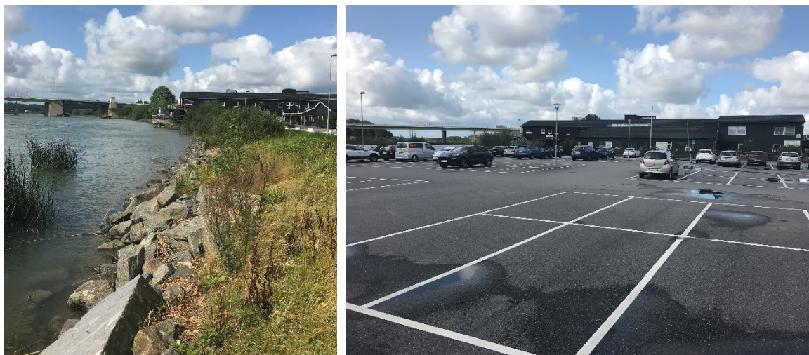
Figur 3-1, 3-2 Utlagda erosionsskydd och vy över det aktuella området
