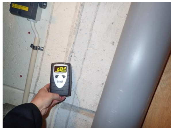
Figur 9. By 4 alla ytterväggar är av blåbetong. Utanför dessa finns äldre plåt och nyare träfasad.
