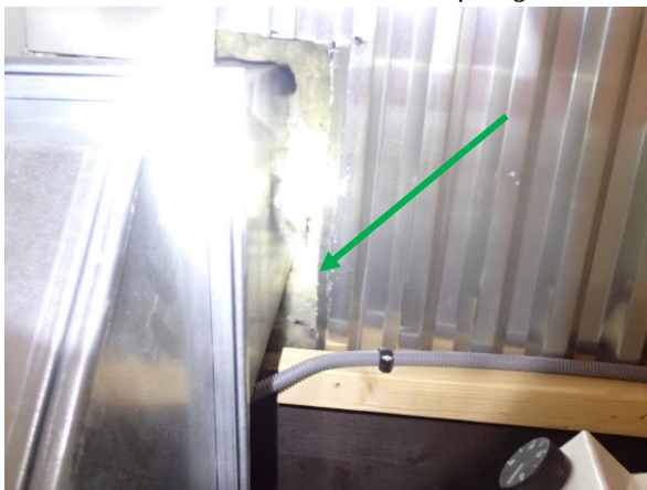
Figur 12. Synligt yttertak i By 4 plan 2 bedöms vara en dubbelplåtkonstruktion med mineralull i mellan enligt kontroller i befintliga hål.
