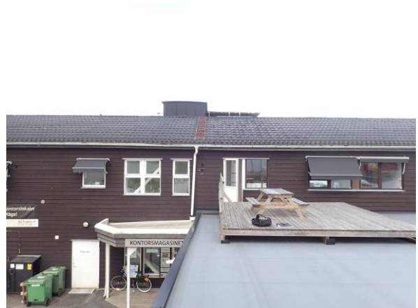
Figur 25. Ventilationsrum på tak by 4 kan var äldre, aggregaten är dock med stor sannolikhet utbytta då alla ventilationskanaler på planet under är nya.
