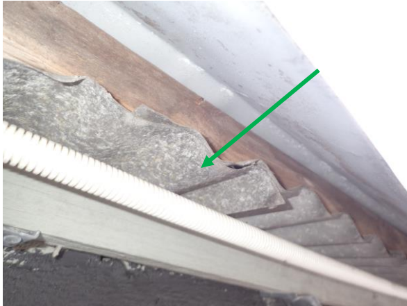
Figur 10. Under nyare yttertak av plåt i Bby 1 och By 4 finns ett äldre plåttak (dubbelplåt isolerad med mineralull), ingen eternit kunde lokaliseras där konstruktionen kunde kontrolleras i befintliga hål.
