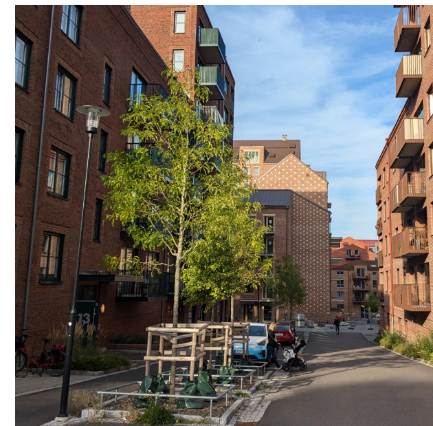
Kvartersgata indelad i tre zoner (gång, parkering och bil) Fixfabriken, Göteborg
