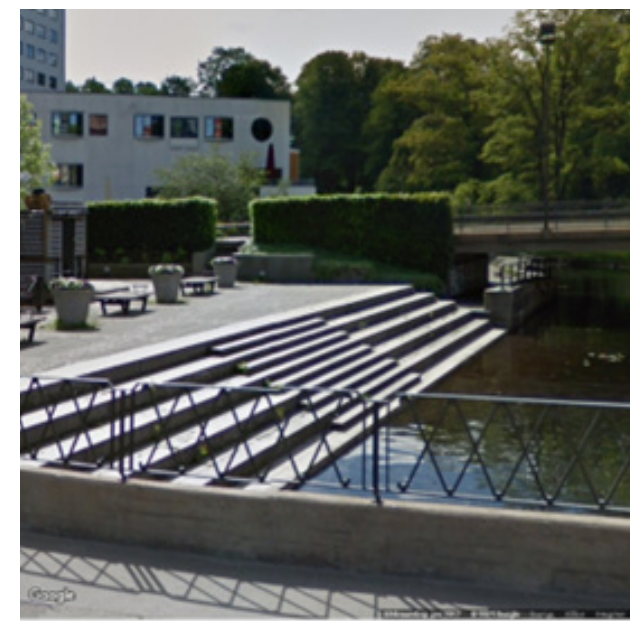
Trappande högvattenskydd ned mot vattnet Stora Brogatan vid Viskan, Borås
