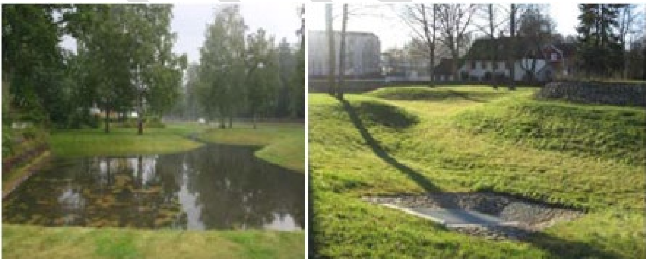
Figur 34; exempel på dagvattendammar i Växjö under torrt och vått väder (SWECO, 2016)
