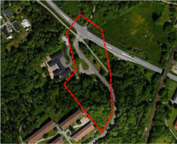
Figur 12. Delområde 1 i den geotekniska utredningen där kvicklera bedöms finnas (COWI AB, 2019-12-20, rev 2020-02-27).
