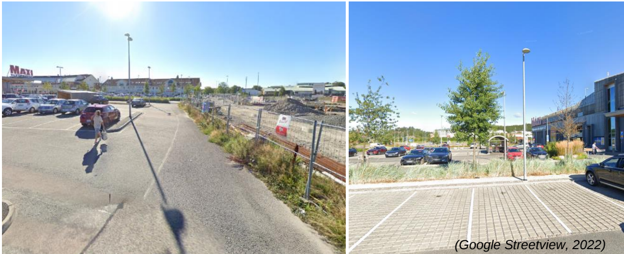
Figur 4:2- Till höger i den vänstra bilden ses planområdets sydvästra gräsbeklädda slänt. I den högra bilden ses parkeringsytornas permeabla beläggning och den växtlighet som finns i de gräsbeklädda slänterna på parkeringsytorna.
