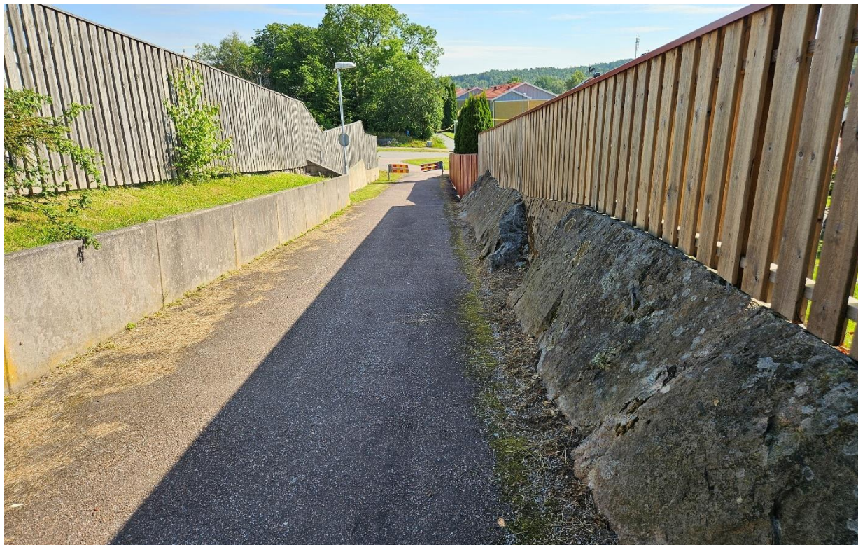
Figur 6-8 – Östra sidan av fastigheten. Foto taget i nordlig riktning 2025-07-14.
